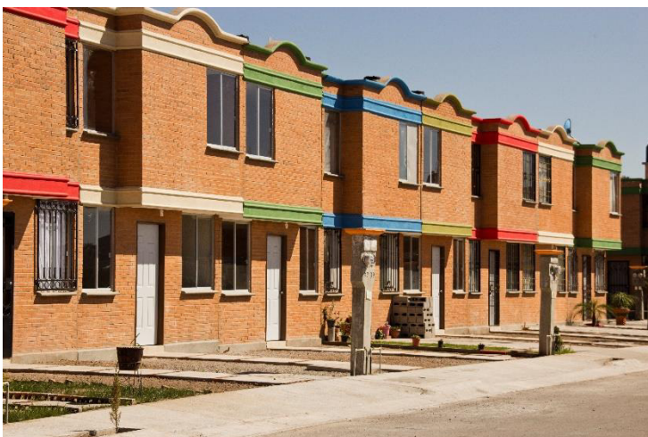
Imagen 32. Tren de Fachadas, Fracc. Arboledas de Cd. Bajío; Salamanca, Gto.
