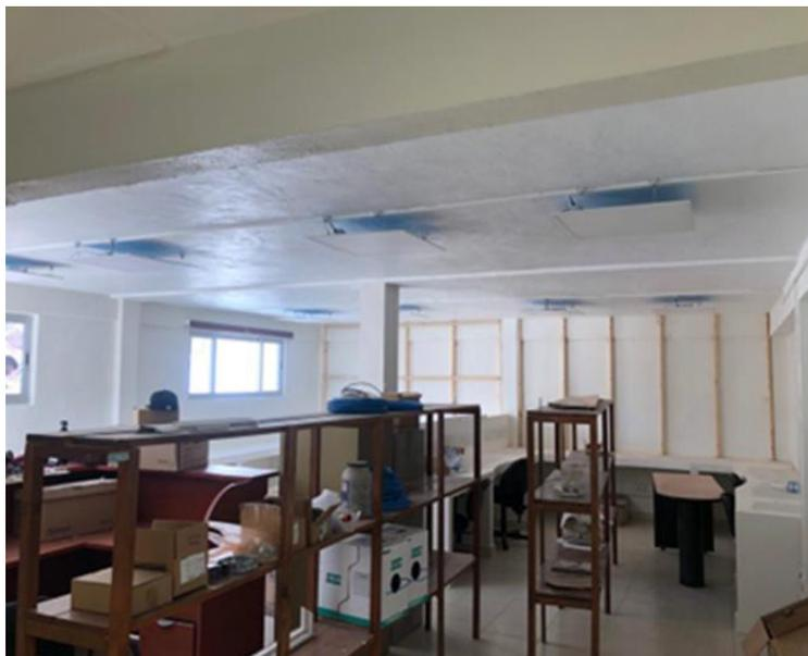
Ilustración 147. Colocación de bastidor de madera para sostener libreo adosado en muro en planta baja de la dirección de asuntos jurídicos. Fotografía por Sergio de Jesús Hernández Rojas.
