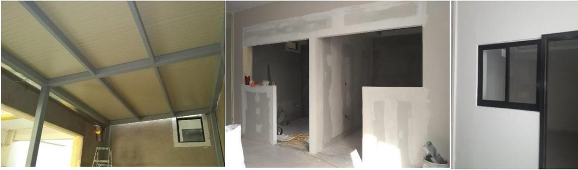
Ilustración 75, 76 y 77. (Derecha) Estructura metálica de acero para recibir cubierta de multytecho (Central) Divisiones a base de muro de panel de yeso a dos aguas, (Izquierda), Suministro y colocación de puertas de tambor y ventanas de aluminio negro corredizas. Fotografías por Sergio de Jesús Hernández Rojas.
