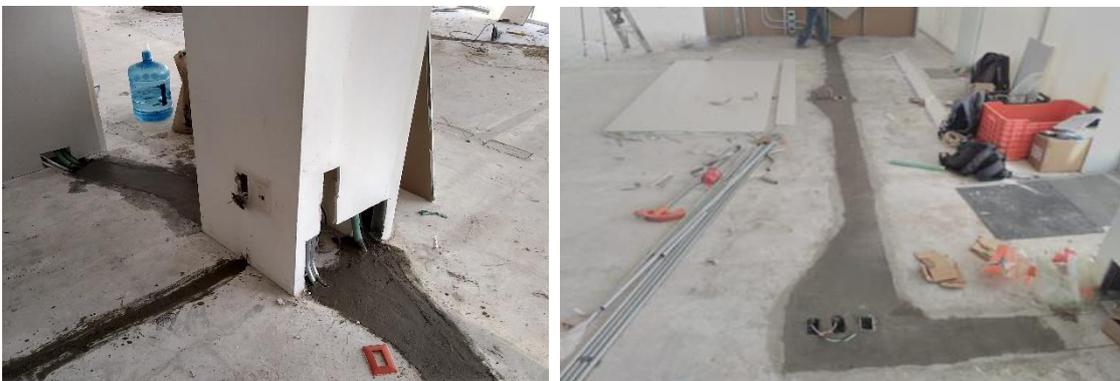
Ilustración 167 y 168. Ranuras en piso para alojar alimentaciones eléctricas en planta baja. Fotografía por Sergio Hernández Rojas.
