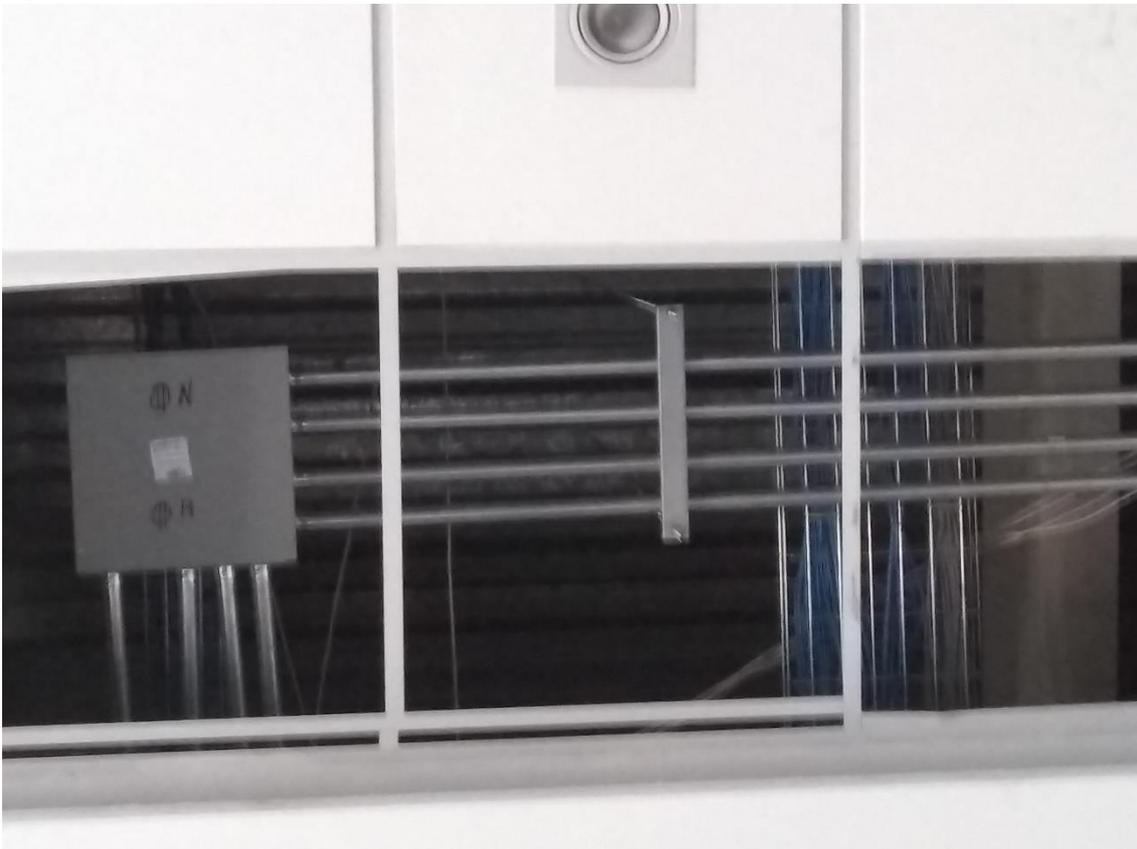
Ilustración 165. Fotografía donde podemos apreciar un registro eléctrico en un cruce de cambio de dirección de 90°, por lo regular siempre en esquinas se coloca un registro para no tener complicaciones al momento de insertar los cables por las tuberías, también podemos la suspensión de tubería que se llevó a cabo debajo de la losa de entrepiso, que está al final de cuentas quedaría ahogada por el falso plafón. Fotografía por Sergio Hernández Rojas.
