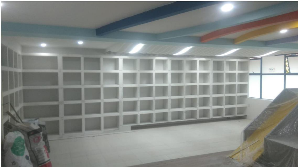
Ilustración 206 y 207. Aplicación de pasta y lijado de superficies de librerías L2, L3 y L4 con lija fina de agua del grano #120. Fotografías por Sergio de Jesús Hernández Rojas.
