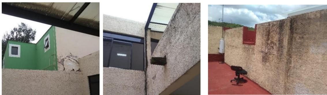
Ilustración 30, 31 y 32. Fotografías que muestran el deterioro en muros por humedad existente en el edificio. Fotografía: Sergio de Jesús Hernández Rojas.
