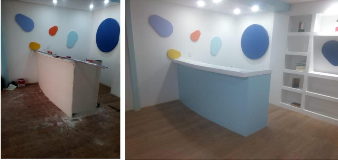
Ilustración 215 y 216. Procesos constructivos para la elaboración de mueble de recepción, (izquierda) colocación de hojas de panel de yeso, (derecha) aplicación de pintura vinílica y colocación de cubierta de MDF. Fotografía por Sergio de Jesús Hernández Rojas.
