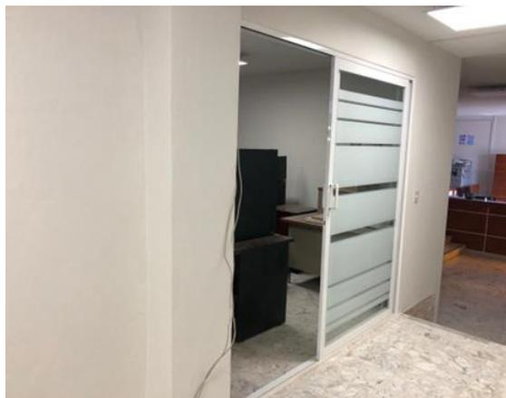
Ilustración 141 y 142. Colocación de división de panel de yeso e instalación de cancel de aluminio en la planta baja de la dirección de asuntos jurídicos. Fotografías por Sergio de Jesús Hernández Rojas.
