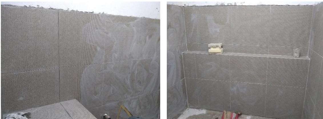
Ilustración 47 y 48. Fotografía (izquierda) Colocación de recubrimiento cerámico en muros y pisos, también podemos ver la aplicación de juntador en las uniones de las piezas para sellar la superficie, Fotografía: por Sergio de Jesús Hernández Rojas.
