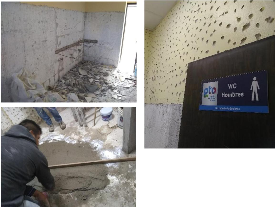
Ilustración 44,45 y 46. Fotografía (izquierda) demolición de recubrimientos cerámicos y barra de concreto de lavamanos. Fotografía (derecha) picado manual de la superficie en muros para mejorar área de adherencia de los trabajos. Fotografía: por Sergio de Jesús Hernández Rojas.
