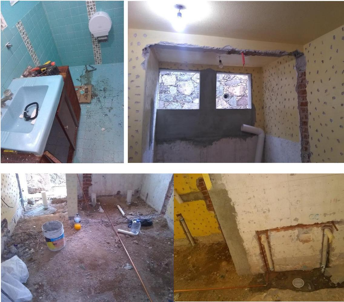
Ilustración 116, 117, 118 y 119, fotografía de baño en planta baja antes de comenzar los trabajos, Fotografía 2. Demoliciones y picado de la superficie para garantizar a la adherencia de los recubrimientos cerámicos, fotografía 3.- Demolición de firme de concreto para adecuar red sanitaria, fotografía 4. Ranuras en muros para alojar tuberías sanitarias. Fotografías por Sergio de Jesús Hernández Rojas
