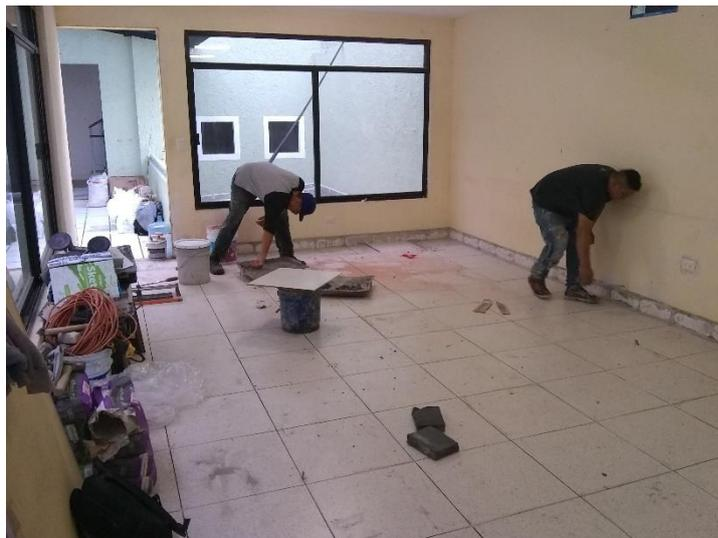
Ilustración 101. Instalación de nuevo recubrimiento cerámico. Fotografía por Sergio de Jesús Hernández Rojas.
