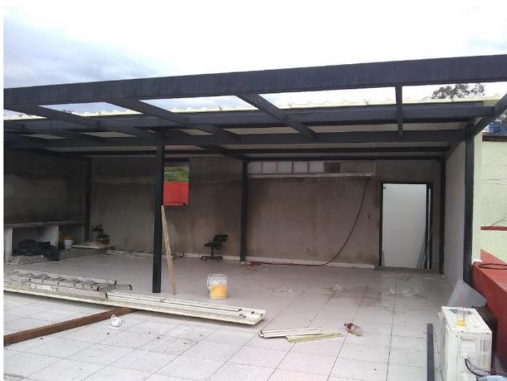
Ilustración 91. Colocación de piso cerámico en toda la azota del inmueble. Fotografía por Sergio de Jesús Hernández Rojas.
