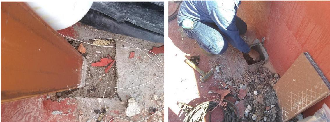
Ilustración 85 y 86. Ranurado en losa de capa de compresión de concreto para colocar placas de acero. Fotografía por Sergio de Jesús Hernández Rojas.
