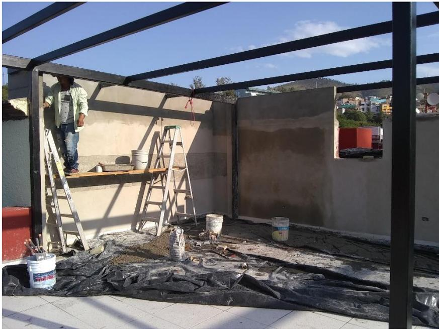
Ilustración 89 y 90. Estructura de Bastidor metálico para comedor en azotea. Fotografía por Sergio de Jesús Hernández Rojas.
