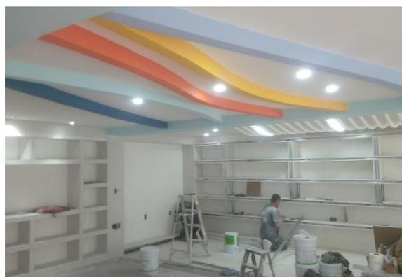
Ilustración 204 y 205. Trazado en muros y colocación de bastidor metálico galvanizado para recibir hojas de panel de yeso. Fotografía por Sergio de Jesús Hernández Rojas.
