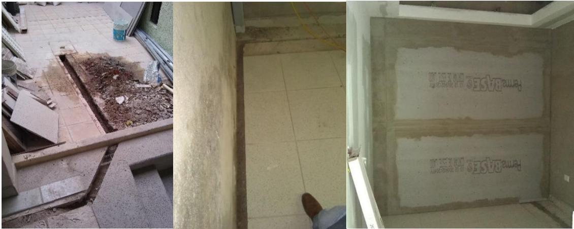
Ilustración 72, 73 y 74. (Derecha) ranurado en piso firme para colocar tubería de desagüe en tubo de PVC de 2”, (Central) forjado de mediacaña de concreto con pendiente del 1.5%, (Izquierda) colocación de muro tapón en material de panel de cemento para ocultar trabajos pertinentes de prevención contra humedades. Fotografías por Sergio de Jesús Hernández Rojas.
