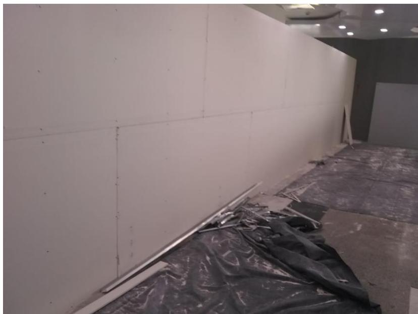
Ilustración 176 y 177. Muros división en material de panel de yeso para aislar el área de trabajo.
