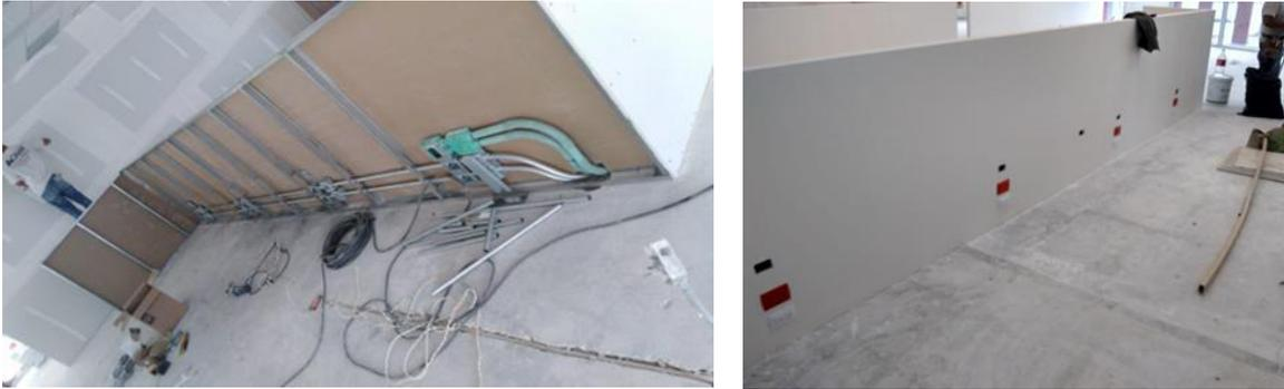
Ilustración 159 y 160. Fotografía izquierda, colocación de instalaciones eléctricas en bastidor metálico galvanizado para sistema de panel de yeso, Fotografía Derecha, Colocación de panel de yeso una vez terminando de colocar toda la ductería tanto eléctrica como de voz y datos. Fotografía por Sergio Hernández Rojas.
