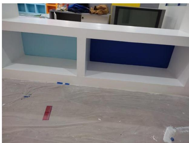
Ilustración 210. Colocación de plástico protector transparente de uso rudo para cuidar piso laminado de salpicaduras de pintura. Fotografía por Sergio de Jesús Hernández Rojas.
