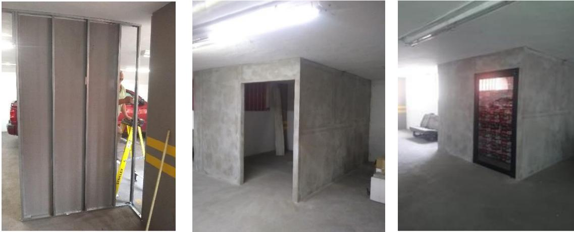
Ilustración 41, 42 y 43. Fotografía (izquierda) donde se muestra la colocación de bastidor metálico y colocación de una hoja de panel de cemento para dar tiempo a colocar todas las instalaciones que irán por dentro de los muros. Fotografías (central y Derecha) bodega de almacén con acabado terminado de pasta multiusos lista para recibir pintura y colocar puertas de aluminio. Fotografía: por Sergio de Jesús Hernández Rojas.
