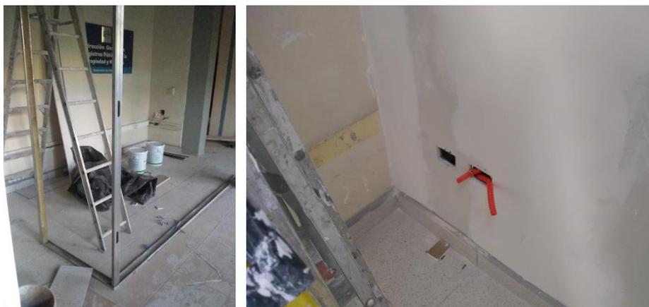
Ilustración 59 y 60. (Izquierda) Colocación de bastidor metálico a base de poste y canal para recibir hojas de panel de yeso, (derecha) Instalación de canalización para instalaciones eléctricas y de voz y datos dentro de muros de panel de yeso recubiertas a dos hojas. Fotografías por Sergio de Jesús Hernández Rojas.
