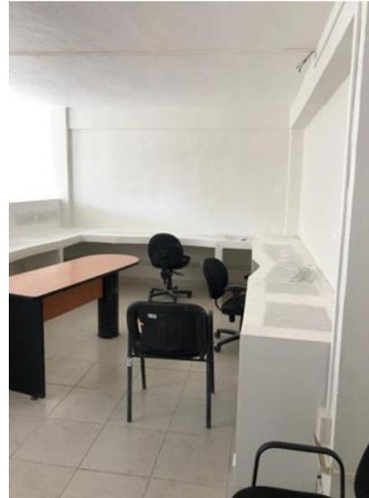
Ilustración 145 y 146. Elaboración de mesas de trabajo en material de panel de yeso para la creación de mesas de trabajo en la planta baja de la dirección de asuntos jurídicos. Fotografía por Sergio de Jesús Hernández Rojas.
