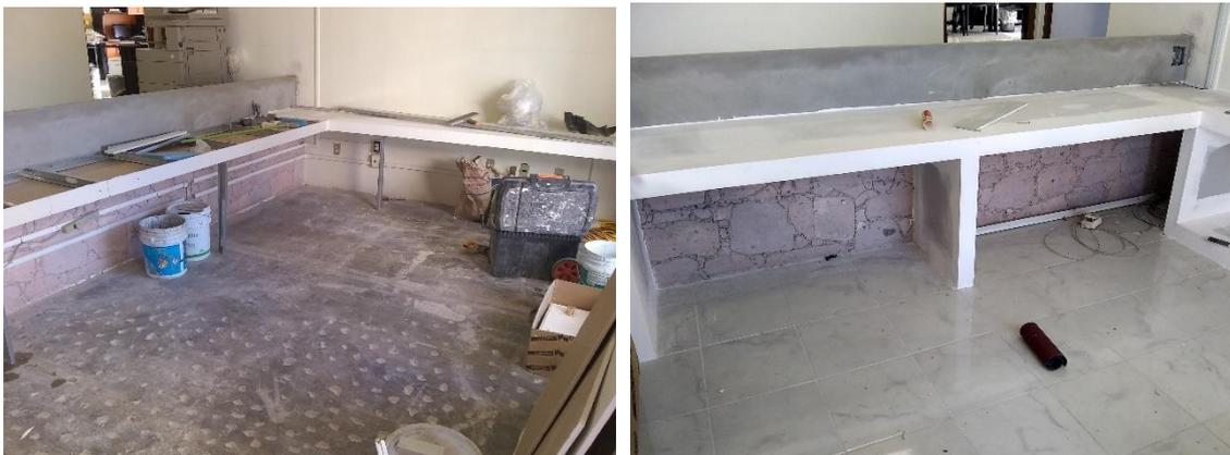
Ilustración 133 y 134. Trabajos de instalación de barra de trabajo a base de bastidor metálico y hojas de panel de yeso para la recepción de la planta baja de la dirección General de Asuntos Jurídicos. Fotografías por parte de Sergio de Jesús Hernández Rojas.
