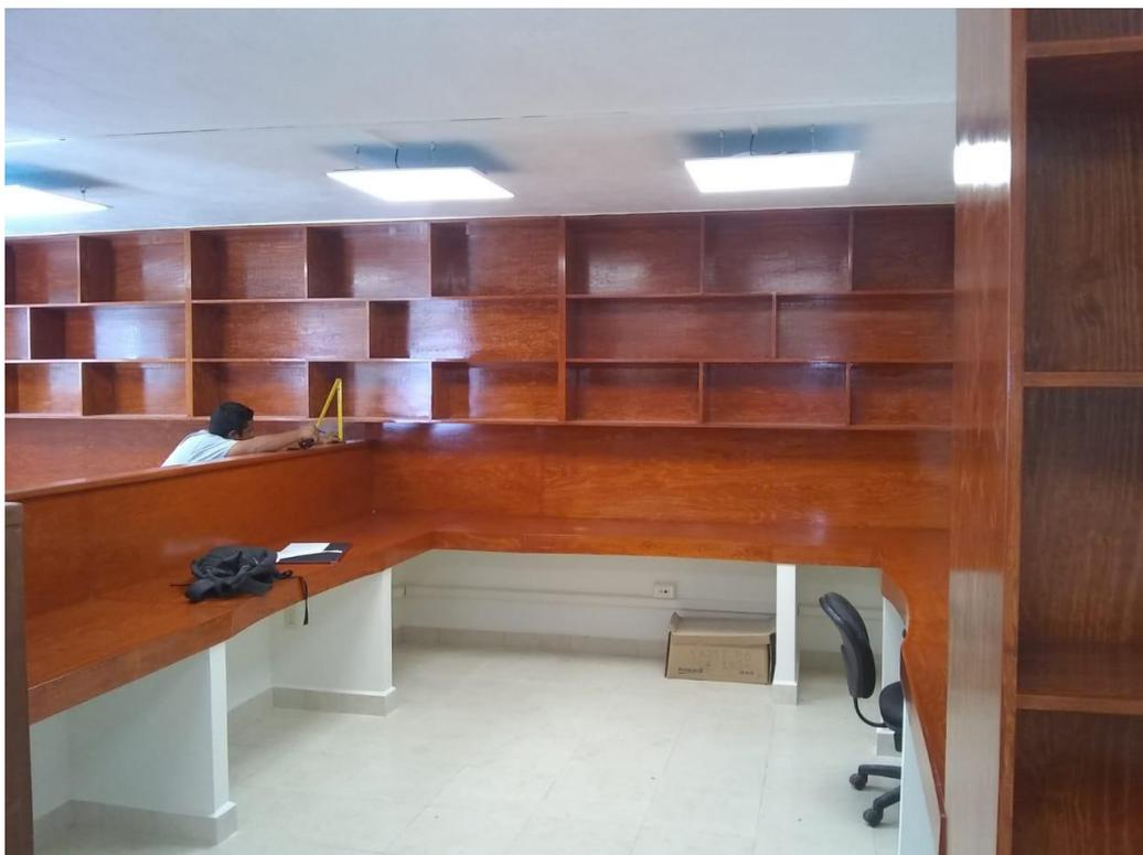
Ilustración 148 y 149. Resultados finales ya con trabajos de carpintería para la creación de mesas de trabajo en planta baja de la dirección de asuntos jurídicos. Fotografía por Sergio de Jesús Hernández Rojas.
