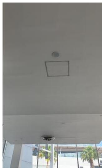
Ilustración 170 y 171, registros en plafón para colocación de tubería suspendida para la instalación eléctrica del edificio del SATEG. Fotografía por Sergio Hernández Rojas.
