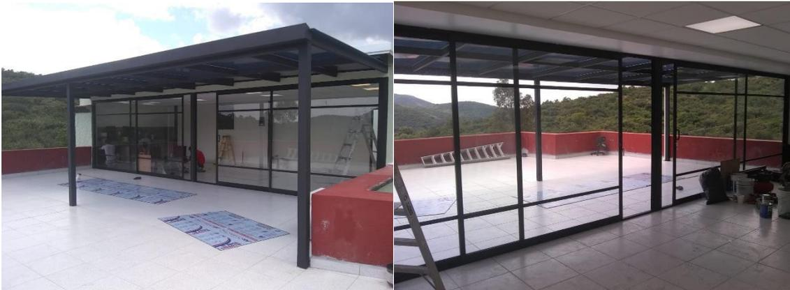
Ilustración 93 y 94. Fotografía izquierda colocación de hojas de policarbonato sobre estructura de acero, fotografía derecha: Cancel de aluminio negro con cristal claro en comedor de la azotea. Fotografía por Sergio de Jesús Hernández Rojas.
