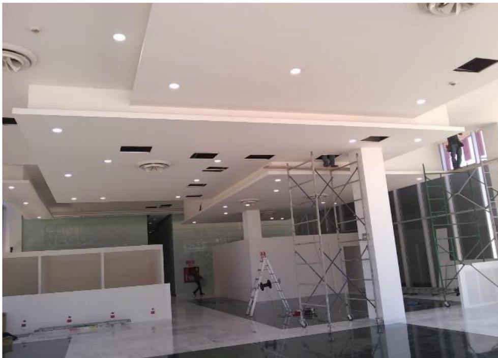
Ilustración 169. Montaje de cuerpos de dos cuerpos de andamios para mantenimiento de luminarias el cual consistió en el cambio de luminarias led de 18 w. Fotografía por Sergio Hernández Rojas.
