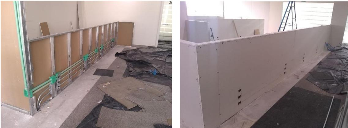
Ilustración 172 y 173. Colocación de tubería para instalaciones eléctricas y de voz y datos en muro de panel de yeso, (izquierda) y muro de panel de yeso recubierto por ambas caras una vez terminados los trabajos de instalación de tubería. Fotografía por Sergio Hernández Rojas.
