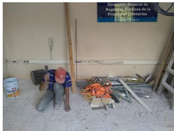
Ilustración 55 y 56. Demolición de piso cerámico en la recepción (izquierda) y desmantelamiento de instalaciones existentes (derecha) en el área de Recepción, Fotografías por Sergio de Jesús Hernández Rojas.
