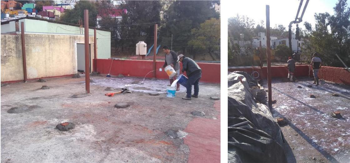
Ilustración 87 y 88. Preparación de la superficie aplicando aditivo para concreto disuelto con agua, para recibir mortero fluido de renivelación. Fotografía derecha podemos ver el vaciado de mortero fluido de renivelación mediante el sistema de bombeo. Fotografía por Sergio de Jesús Hernández Rojas.
