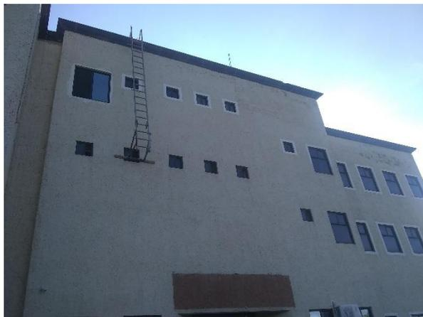
Ilustración 66. Montaje de escaleras metálicas para poder realizar los trabajos de pintura en la fachada principal del inmueble. Fotografías por Sergio de Jesús Hernández Rojas.
