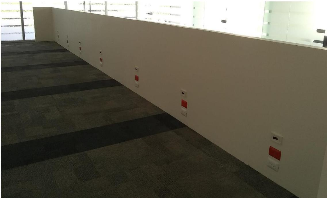
Ilustración 161. Fotografía del resultado final, una vez terminado el proceso de pasta y pintura, y al haber realizado todo el proceso de cableado por la tubería, se procede a colocar los tomacorrientes (blancos normales, naranjas regulados). Fotografía por Sergio Hernández Rojas.
