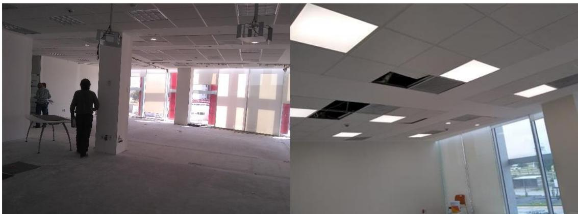
Ilustración 162 y 163. Cambio de luminarias fluorescente por panel led, en luz blanca. Fotografía por Sergio Hernández Rojas.
