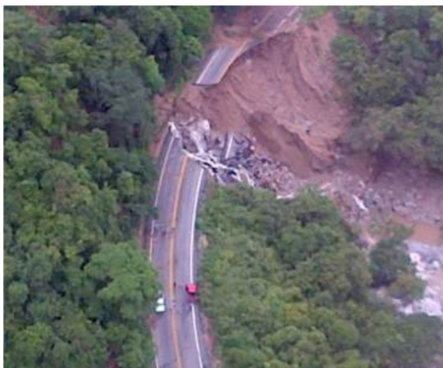
Imagen 2: Carretera México-Acapulco, destruida durante el paso del huracán Manuel , Septiembre 2013.
