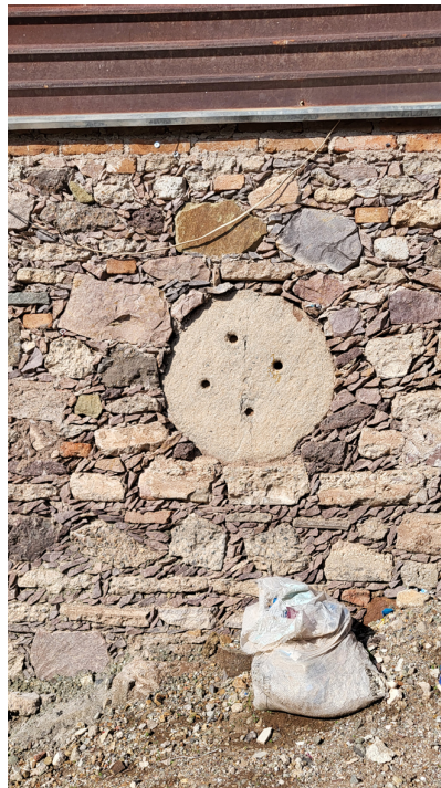
Figura 5. Alcantarilla, segundo uso. Sara Sofía Parrales, 2024
