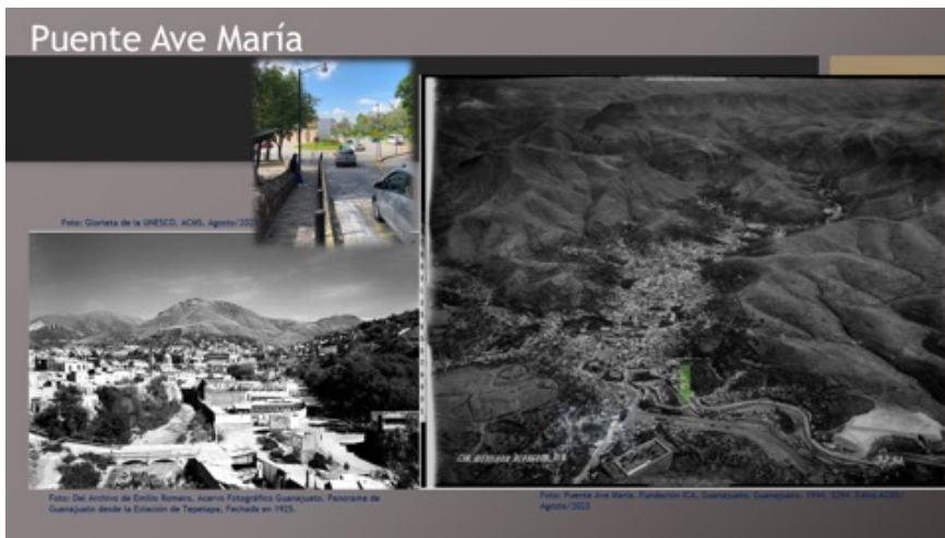
Imagen 6.9. Puente Ave María. ACMS/2023.
