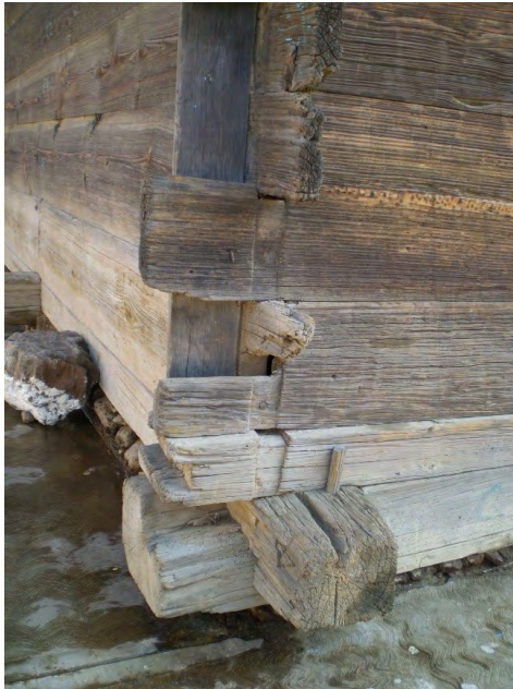
Imagen 10. Detalle de ensamblaje en esquinas de muros de una troja.
