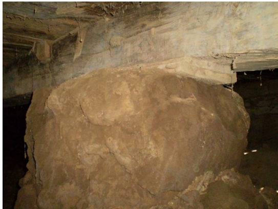
Figura 96. Poyo con viga principal, aquí se aprecia la unión entre vigas denominada “rayo de Zeus”. Fotografía: María de Jesús Moreno Estrada (2019).
