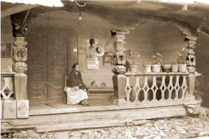
Imagen 19. Pórtico de vivienda purépecha. Fuente: Carlos García Mora (2014).
