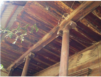
Imagen 16. Viga y columnas en portal que soportan el tapanco en troja. Imagen 17. Rayo de Zeus. Fotografías: María de Jesús Moreno Estrada (2019).
