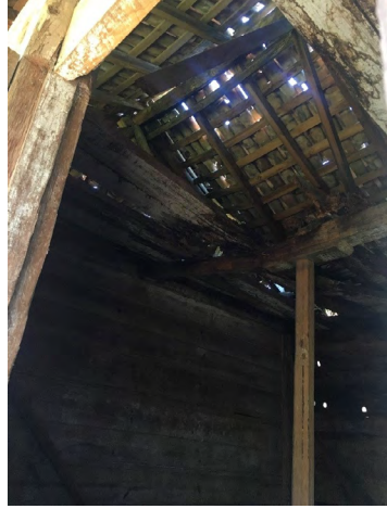
Imagen 120. Faltante de piso en galería. Imagen 121. Faltante en tapanco con tijera volando. Fotografías: María de Jesús Moreno Estrada (2019).
