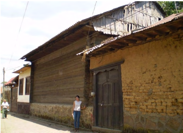
Imagen 48. Troja de aproximadamente 10 metros de altura, calle Benito Juárez. Fotografía: María de Jesús Moreno Estrada (2019).
