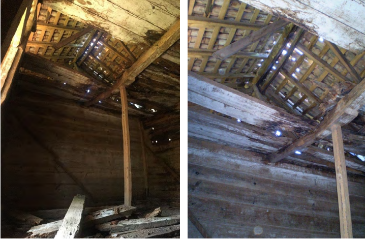
Imagen 110. Habitación 5 al interior.
