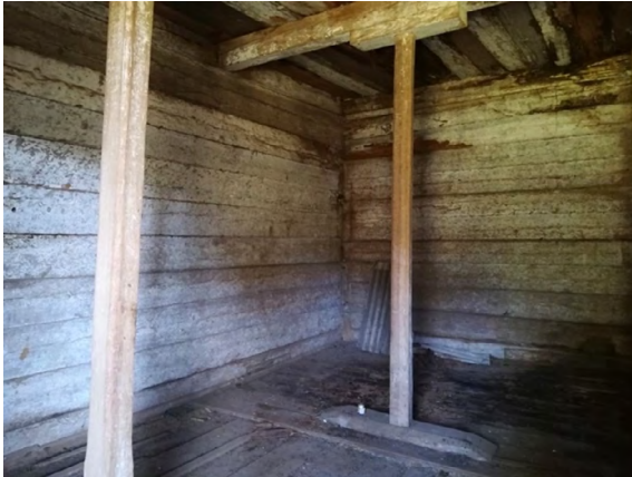
Imagen 105. Esquina formada por la intersección de los muros. Fotografía: María de Jesús Moreno Estrada (2019).
