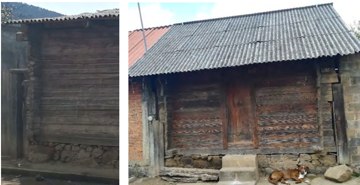
Imagen 32. Cimentación de mampostería en trojas. Fotografía: Daniela Meneses Plascencia (2019).
