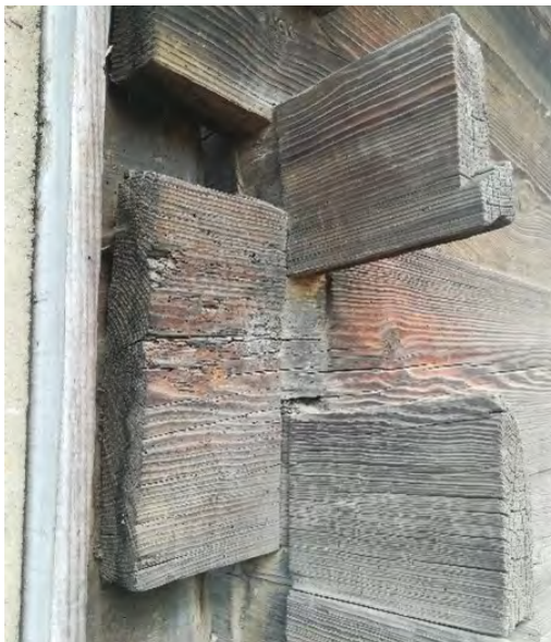
Imagen 34. Detalle de intersección de muros.
