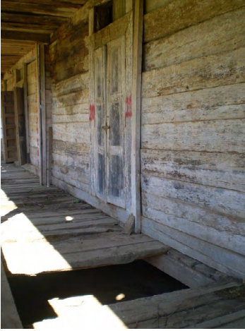
Imagen 120. Faltante de piso en galería. Imagen 121. Faltante en tapanco con tijera volando. Fotografías: María de Jesús Moreno Estrada (2019).
