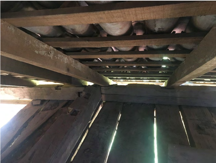
Imagen 117. Pares de cubierta con teja. Fotografía: María de Jesús Moreno Estrada (2019).
