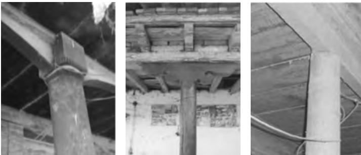
Imagen 37. Unión de vigas con columnas. Fuente: J. Bedolla Arroyo (s/f).
