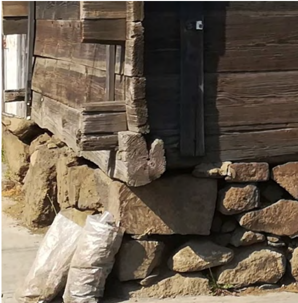
Imagen 33. Detalle de intersección arrastres. Fotografía: Daniela Meneses Plascencia (2019).
