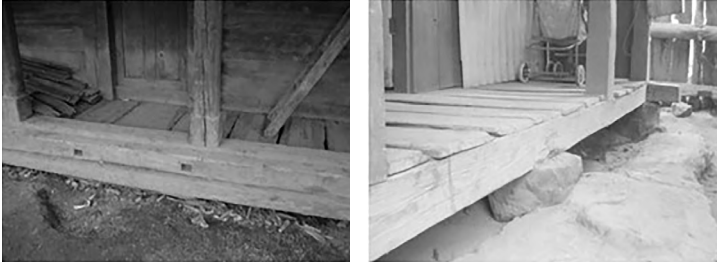
Imagen 35. Piso elevado en troja. Fuente: J. Bedolla Arroyo (s/f).
