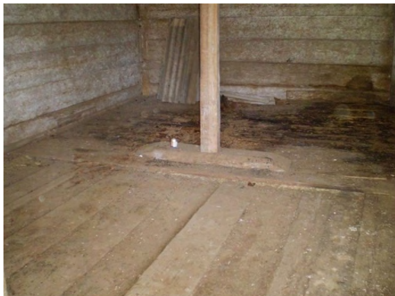
Imagen 108. Doble entablado en piso. Fotografía: María de Jesús Moreno Estrada (2019).
