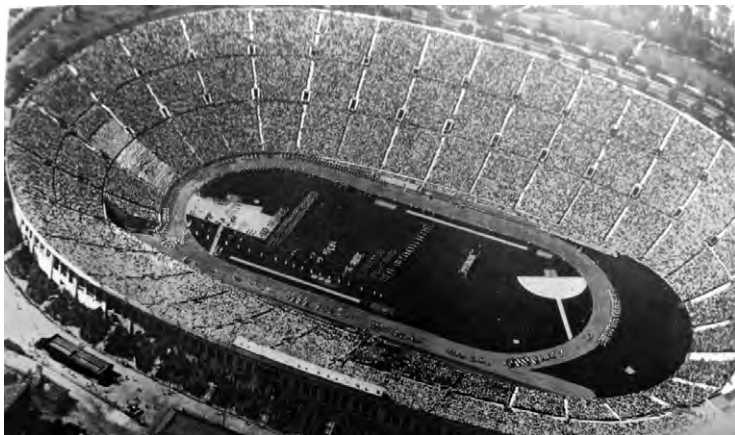
Ilustración 13. Estadio olímpico de Los Ángeles durante los Juegos de 1932. Fuente: Galí, Turbulento, 1970, p. 288.
