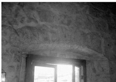
Izquierda: **Figura 25.** Enlace de dovelas de platabanda y jambas de marco de ventana con muro de sillares, casa del cura Juan Bruno de Luna.
