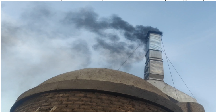
Figura 4. Chimenea de horno ladrillero MK2.
