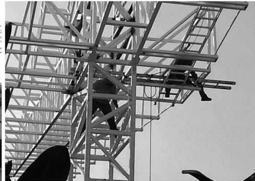
En la imagen izquierda se aprecia el proceso de montaje de la estructura desde el lado norte del patio y en la imagen derecha se observa a los operarios montando y soldando los elementos de la estructura.
