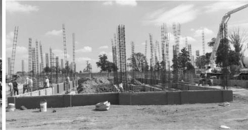
Se aprecia en primer plano el área del edificio de aulas de preparatoria y a la derecha bombeo de concreto en las aulas de secundaria.
