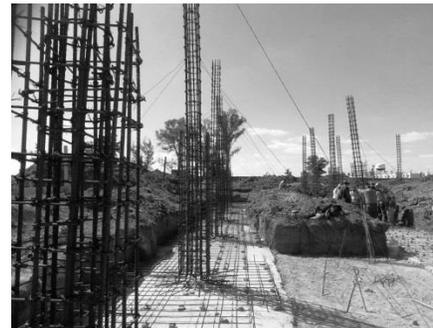
Imagen donde se aprecia el desplante de la cimentación. Fotografía de LF Michel B.
