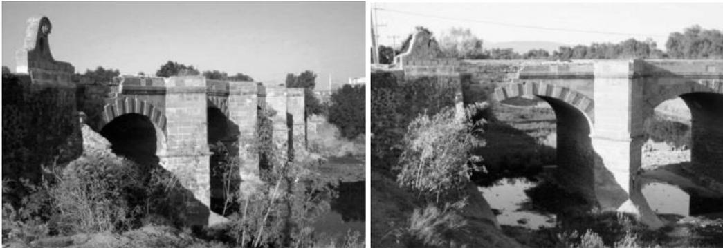
Imágenes del Puente desde el margen poniente del Río Laja y hacia la cara sur del mismo. Se observa deterioro y pérdida de piezas de cantería en el cuerpo del puente y en el arco de su extremo izquierdo. Fotografías de E. Villanueva G.
