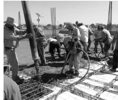
Imagen donde se aprecia el vaciado por bombeo en el colado de la primera losa.
