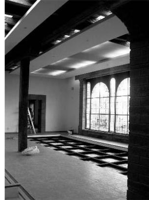
Imagen tomada durante la intervención del inmueble y colocación del plafón y del panel de cristal combinado con el piso de cerámica. Fotografía de LF Miichel B.
