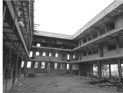
En la imagen izquierda se aprecia el proceso de la obra hasta su último nivel colado en la fachada de acceso al módulo de preparatoria, y en la imagen derecha tomada desde el patio central se aprecia la planta baja libre y los dos niveles de aulas ya colados y en proceso de aplanados.
