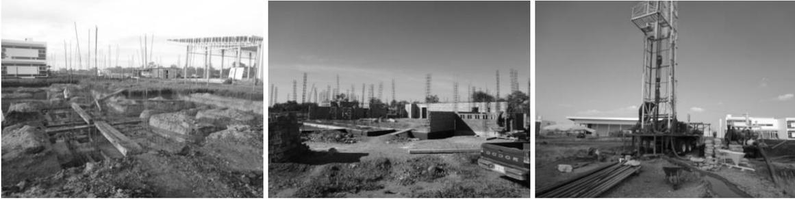
De izq. a derecha: excavación de cimentación de la Capilla. Desplante de muros en casa de las religiosas y maquinaria de perforación del pozo de agua.
