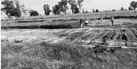
Imagen al inicio de obra. Se aprecian trazos en el terreno. Fotografía de LF Michel B.
