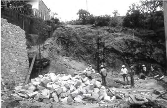
Imagen de la obra donde se aprecian parte de las maniobras de movimientos de tierra, el muro de contención y la excavación en la roca.
