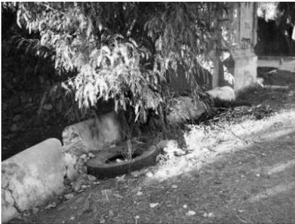
De izquierda a derecha imagen de pilón donde se observa deterioro, falta de piezas de cantería y grafiti; obelisco con faltante de piezas de cantera en su parte inferior y grafiti; remate superior de las pilas donde se observa maleza y falta de piezas de cantera; y, abajo, parte del pilón de inicio con guarnición fracturada, en mal estado y con maleza. Fotografías de E. Villanueva G.
