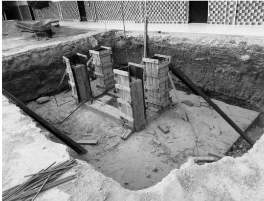
Imagen de la zapata colada con sus cuatro dados que recibirán la carga de la columna del lado oriente.
