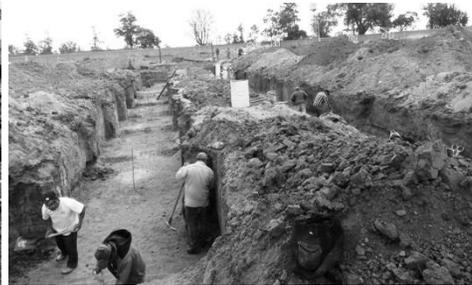
Imagen donde se aprecian las excavaciones y el nivel de desplante de cimentación. Fotografía de LF Michel B.
