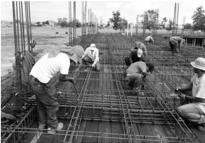
Imagen donde se aprecia el armado de la primera losa del edificio de preparatoria.
