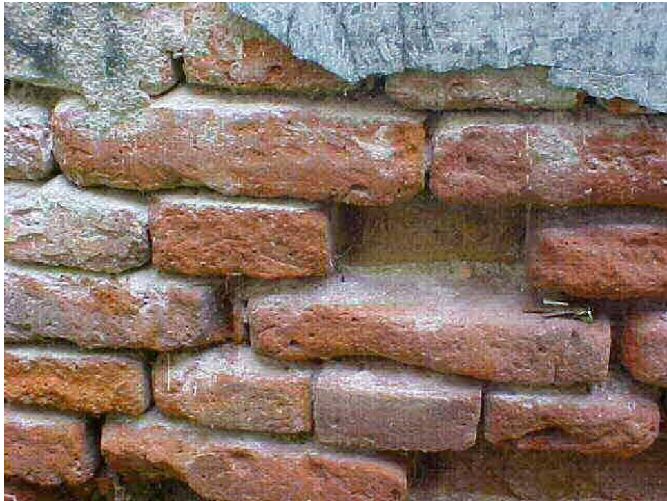
Imagen 58 Detalle de Muros Crujía I
