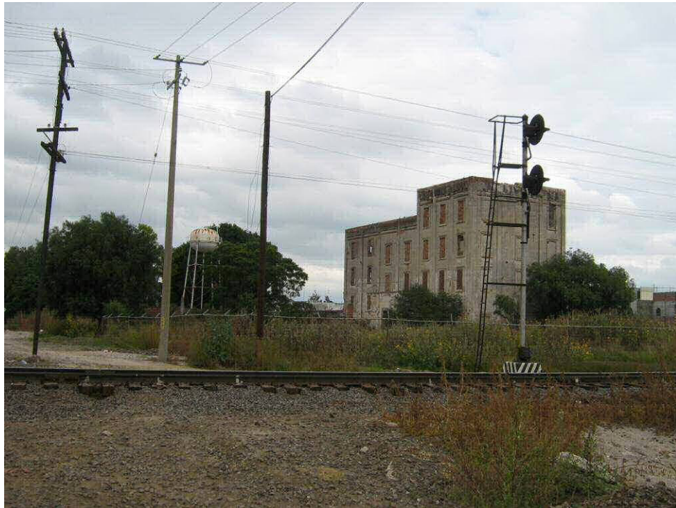
Se observan líneas eléctricas, ducterías de PEMEX y Vías del Ferrocarril Fuente: Archivo del autor
