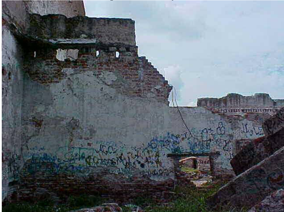
Imagen 65 Muros Crujía IV
