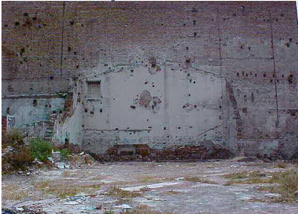
Imagen 66 Exterior lado norte
