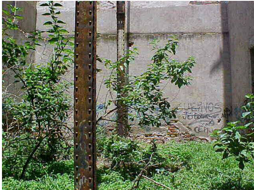
Se observa la estructura metálica (Fm4)
