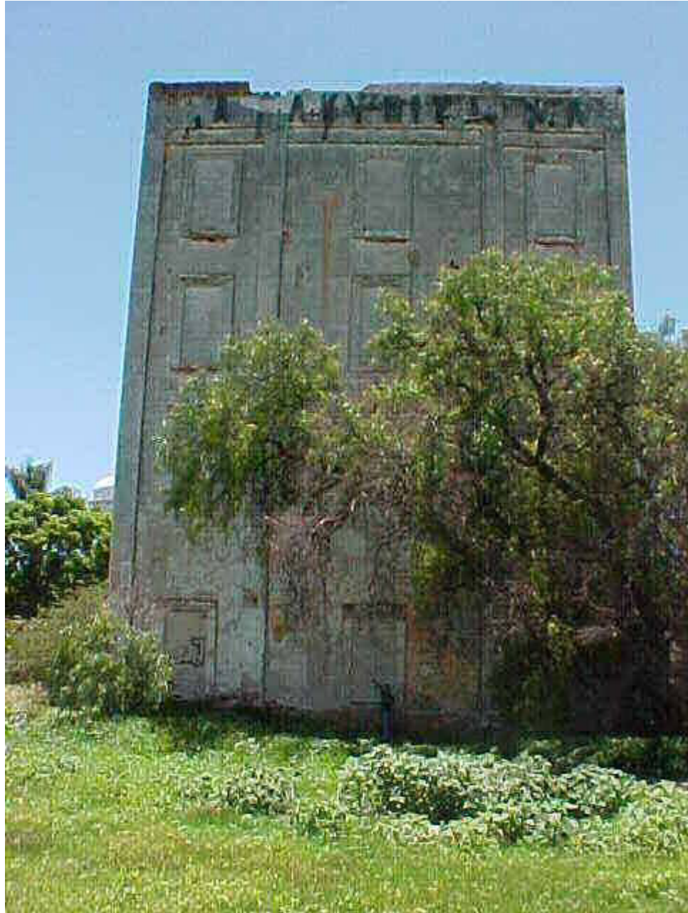
Se aprecia el número de vanos en la fachada oriente. Tapiados actualmente (Fa1)
