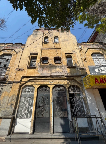
Imagen 11. Viviendas Duplex en Coahuila 53, Roma Sur. Fuente: Autor: 2024
