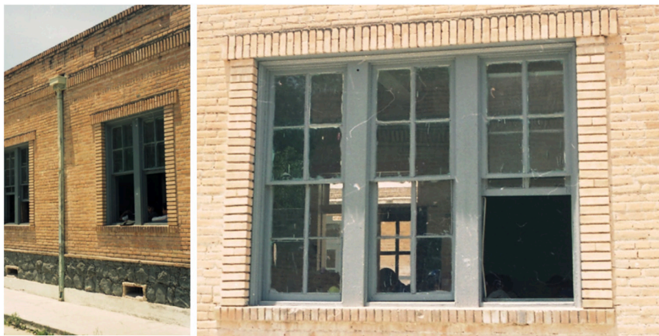
Figura 12. Ventanas de herrería de guillotina de dos y tres módulos. Proporción muy déco. Fotografía de la escuela Centenario. Fotografía T. Trueba. Dolores Hidalgo, Gto. 2009
