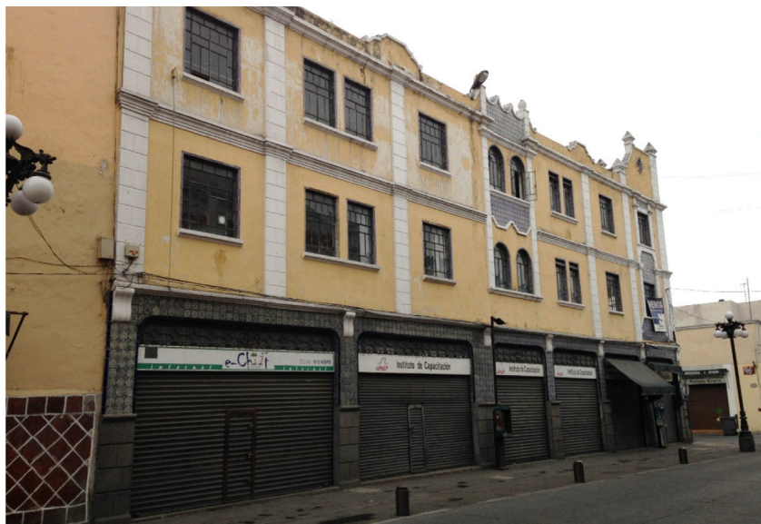
Figura 2. Edificio “Ponchito” de la ciudad de Puebla. Un Art Déco con elementos historicistas barrocos, y detalles funcionalistas como las ventanas y los locales comerciales, llamado “decó poblano”. En 1987 le retiraron las marquesinas de talavera originales, por considerarse no adecuadas en el momento de la inscripción en la lista del Patrimonio Cultural de la Humanidad de UNESCO. Centro histórico de la Ciudad de Puebla, Pue.
