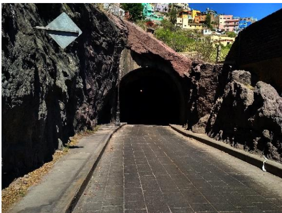
Ilustración 120. Túnel El Barretero (Paseo de la Presa).
