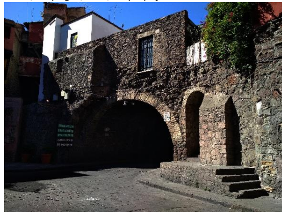
Ilustración 119. Túnel Los Ángeles.
