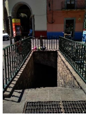
Ilustración 89. Entrada peatonal por la Plaza del Baratillo
