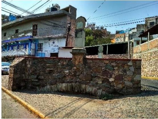
Ilustración 62. Puente del Divino Rostro.
