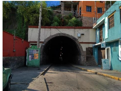
Ilustración 126. Túnel Santa Fe (por San Clemente).
