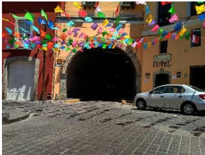
Ilustración 125. Túnel Santa Fe (por Juan Valle).
