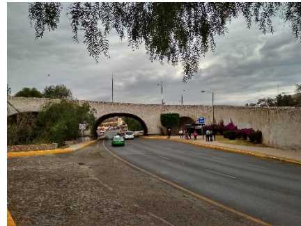
Ilustración 116. Distribuidor vial Noria Alta.
