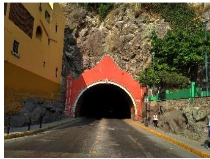
Ilustración 124. Túnel Gustavo Díaz Ordaz (por Dos Ríos).
