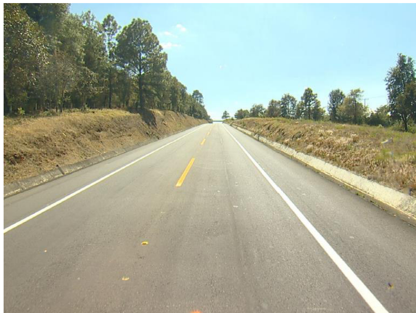
Figura 67 Vista del km 64+500
