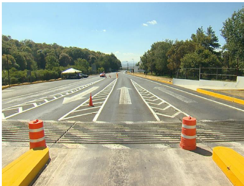
Figura 57. Vista del km 60+500. Caseta de cobro
