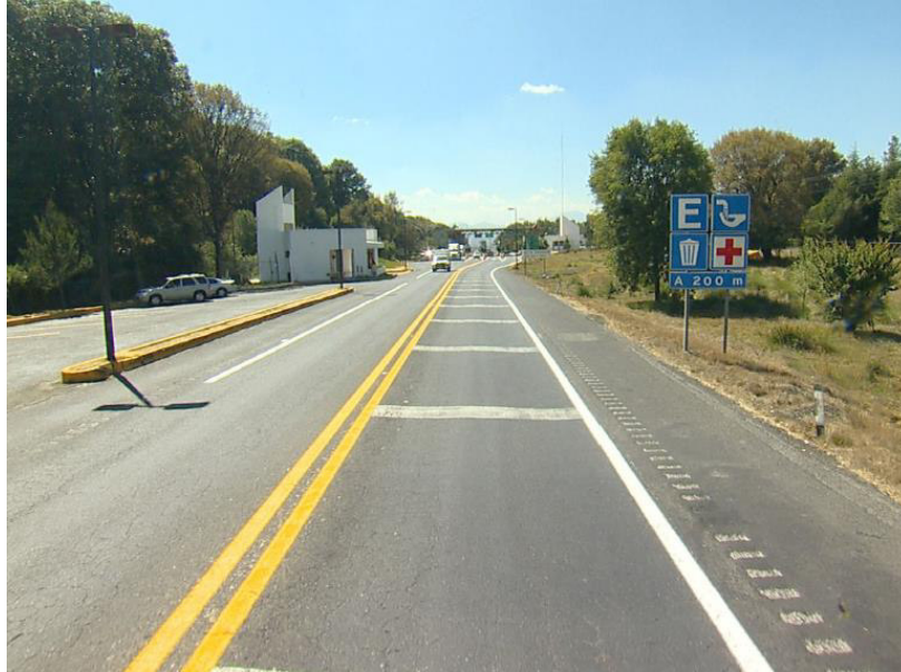
Figura 64. Vista del km 60+300. Caseta de cobro.
