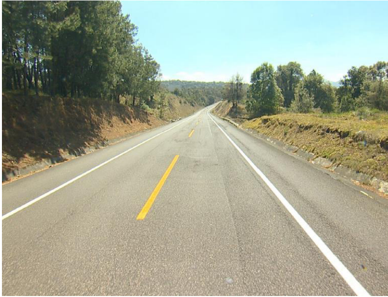
Figura 68 Vista del km 65+500
