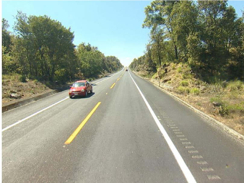
Figura 60 Vista del km 56+830.
