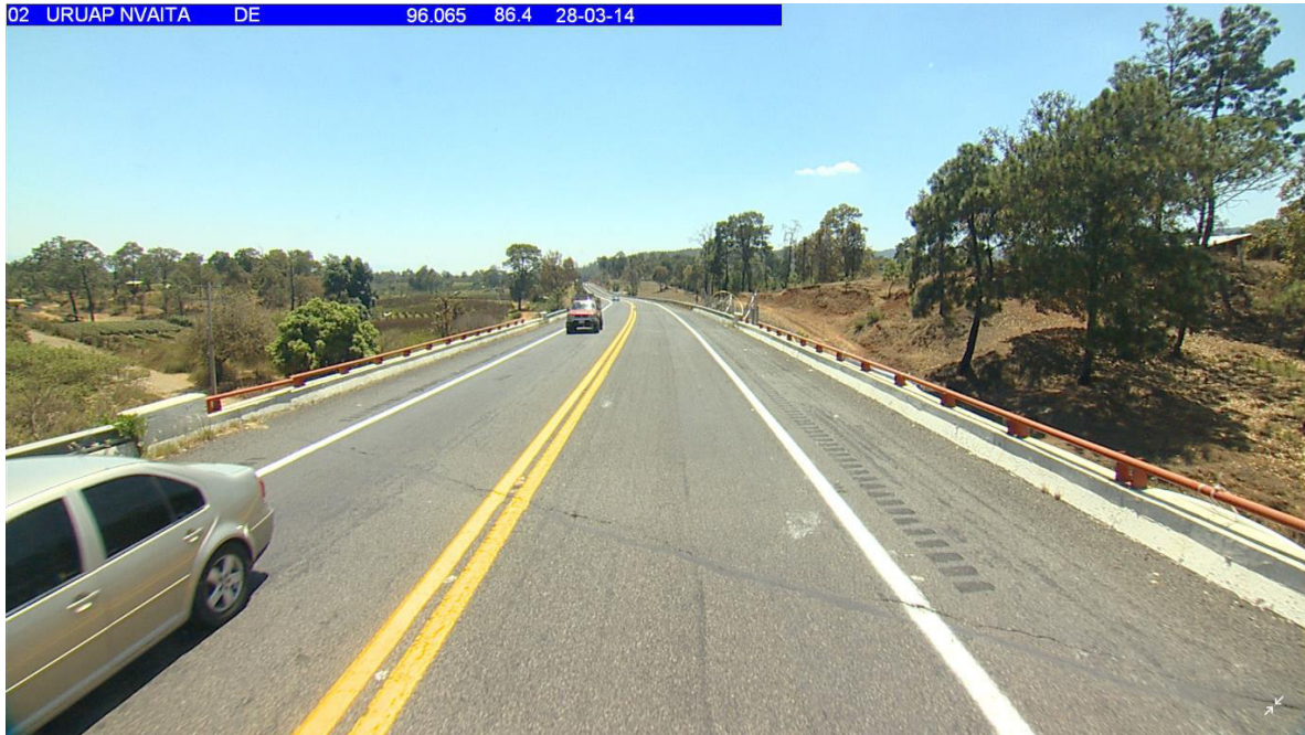
Figura 72. Vista del puente ubicado en el km 96+065
