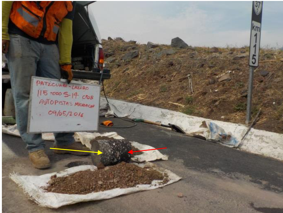
Figura 45. Sondeo realizado en el km 115+000
