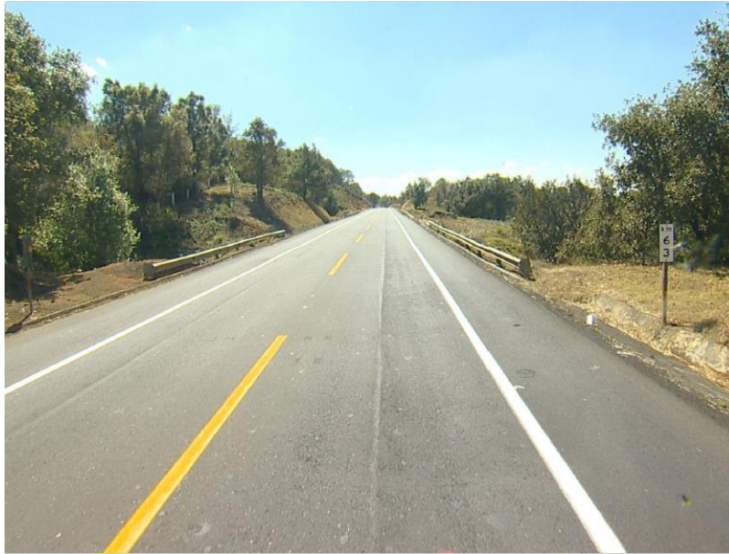
Figura 66 Vista del km 63+000
