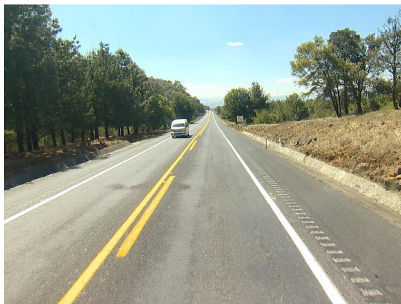
Figura 63. Vista del km 59+700
