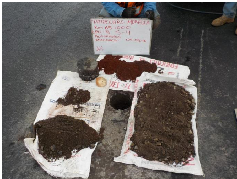
Figura 44. Sondeo realizado en el km 65+000
