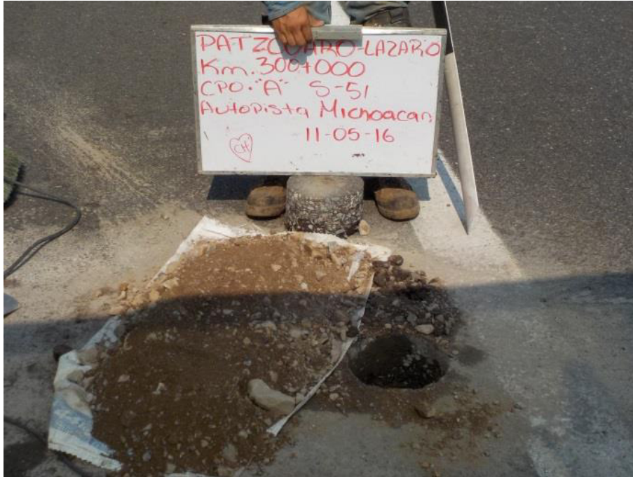
Figura 46. Sondeo realizado en el km 300+000
