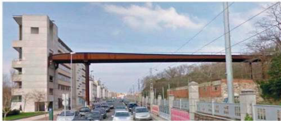
Pasarela PEatonal. Protege las ías del tren a su paso por Mundaiz, La pasarela conecta un edificio de comunicación formado por un ascensor y escaleras.
