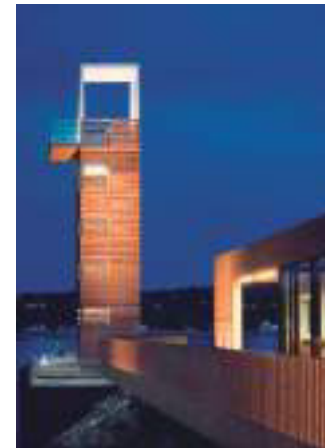
IMAGEN 39 ELABORACIÓN ANDREA POLANCO PUENTE PEATONAL
