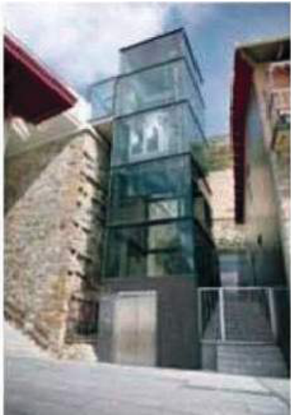
Ascensor del Aquarium facilita la continuidad del paseo Nuevo de la parte superior con la inferior.
