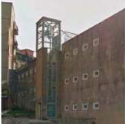
Ascensor público de Sagües fue contruido en 2002. Con 10 m de altura
