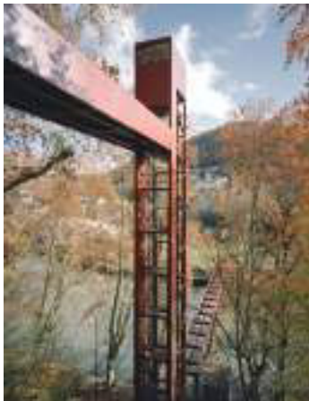
IMAGEN 37 ELABORACIÓN ANDREA POLANCO PUENTE PEATONAL
