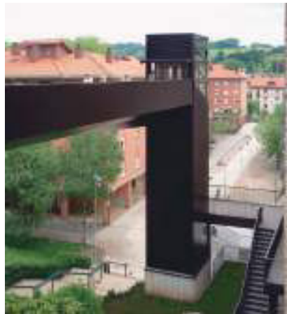
IMAGEN 38 ELABORACIÓN ANDREA POLANCO PUENTE PEATONAL
