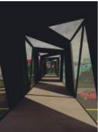
IMAGEN 36 ELABORACIÓN ANDREA POLANCO PUENTE PEATONAL
