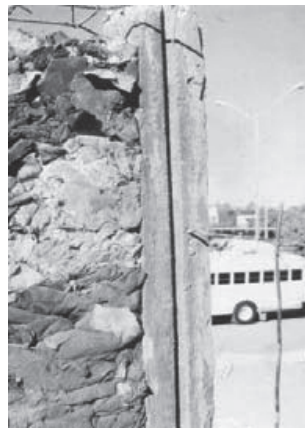
Figura 21. Muro C, área 5 ranuras en el castillo.
