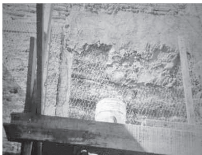
Figura 14. Muro A área 4.
