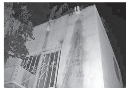
Figura 27. Aspecto exterior de la construcción.
