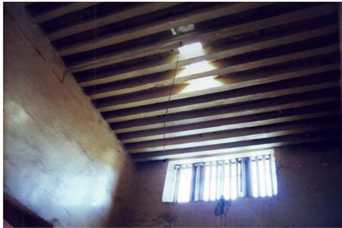
**FOTOGRAFÍA 50:** Techumbres de terrado. Techumbres en mal estado. Las techumbres en esta parte se resolvieron en base al sistema de terrado y barro con vigería de madera. (JLGG)
