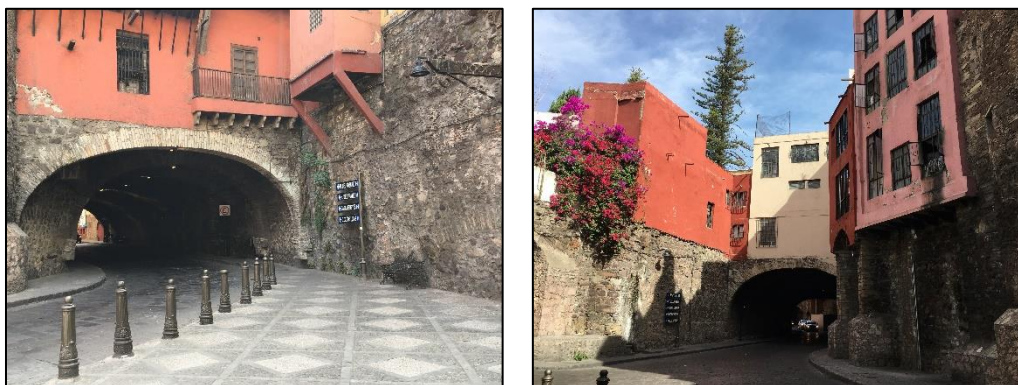
Figura 5 Calle subterránea "Miguel Hidalgo" (fuente propia).
