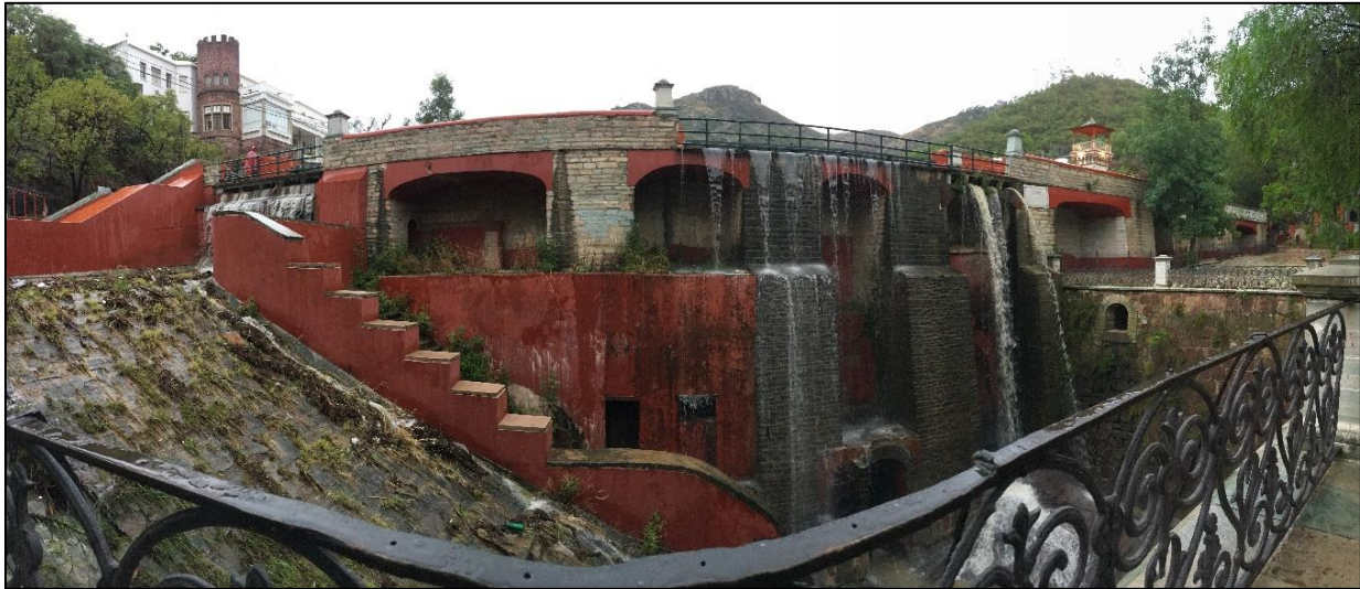
Figura 13 Vertedor de la presa de la Olla (fuente propia, junio 2018).
