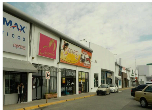
Ilustración 21. Fachada Principal. Fuente: Elaborado por el autor
