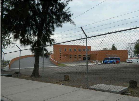
Ilustración 16. Fachada principal Biblioteca. Fuente: Elaborado por el autor
