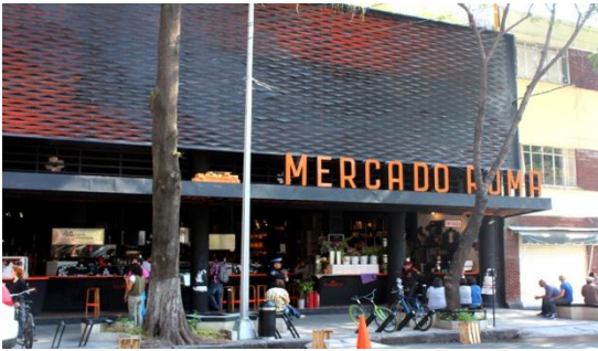
Ilustración 30. Fachada principal Mercado Roma. Fuente: Tomada desde http://www.archdaily.mx/mx
