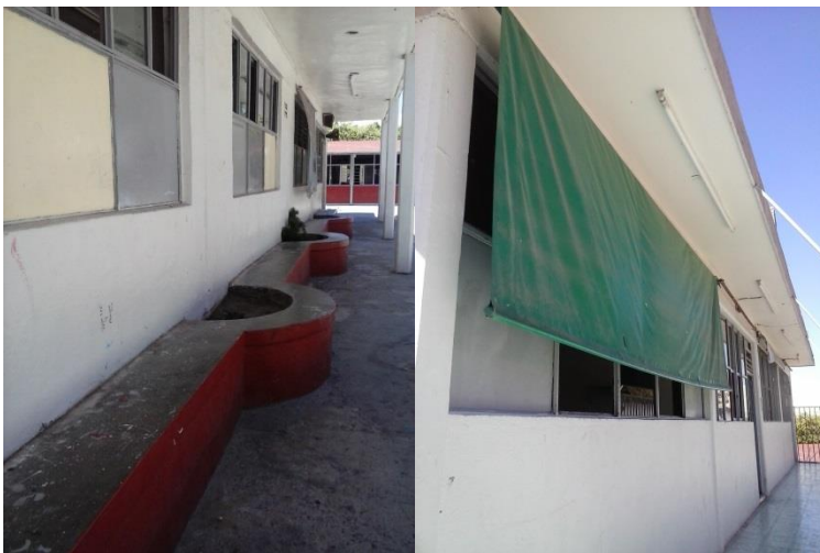
Ilustración 28 Interior de las Aulas
