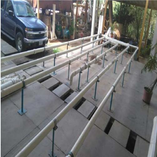
IMAGEN 1: serpentín de PVC con válvula de cierre rápido
