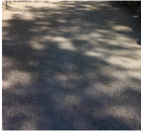
Ilustración 23: Pavimento a base de concreto sin acabado. Autoría propia.
