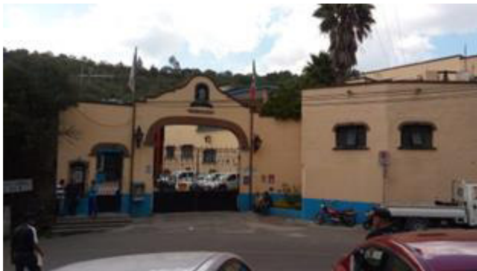
Ilustración 46: Fachada de la Ex-Hacienda de Bustos. Autoría propia.
