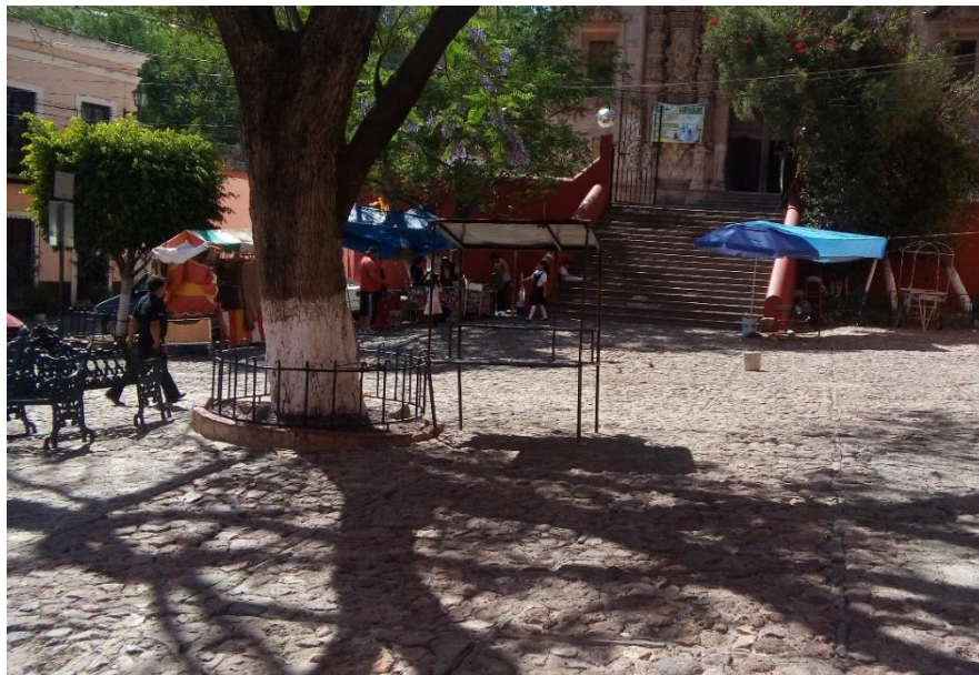
Ilustración 21: Pavimento de piedra bola en la Plazuela de Don Quijote en el Mineral de Cata. Autoría propia.
