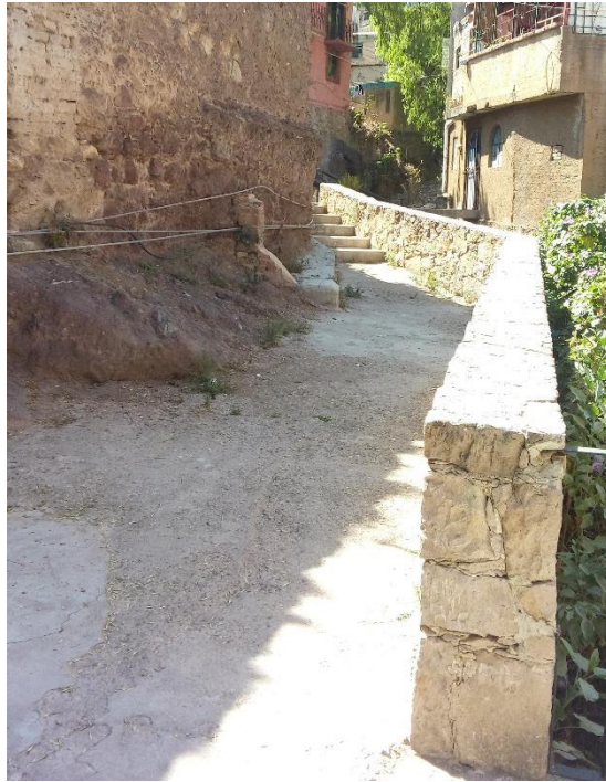
Ilustración 55: Vialidad con accesibilidad sólo peatonal (Callejón del Espejo del Burro). Autoría propia.
