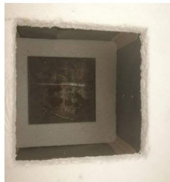
Figura 2. Colocación de placa dentro del dispositivo
