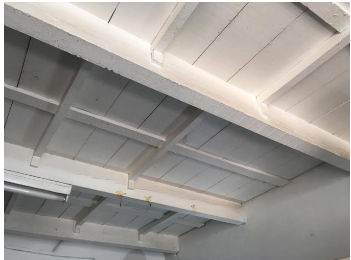
Figura 6. Traveses de madera en entrepiso de la vivienda
