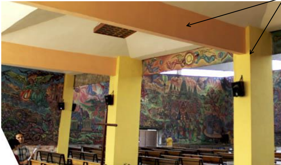
Trabes y columnas en Nartex, iglesia de Santa Teresita. Fotografía tomada por X.J.F.G. (2017).
