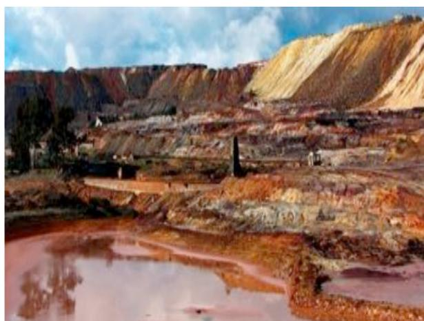
Imagen 115. Explotación de mina a cielo abierto y el característico color del agua (rojizo), su color es causada por la erosión de los minerales.
