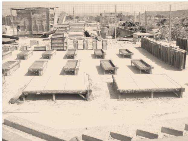
Fig.77. Proceso de construcción de escaleras (CPI)
