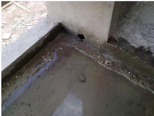
Fig.57. Preparación de desagüe colocado en estructuras
