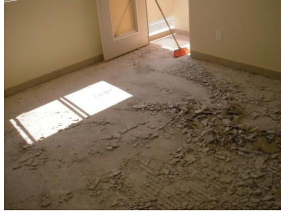
Fig.66. Limpieza de recámara para recolocar loseta
