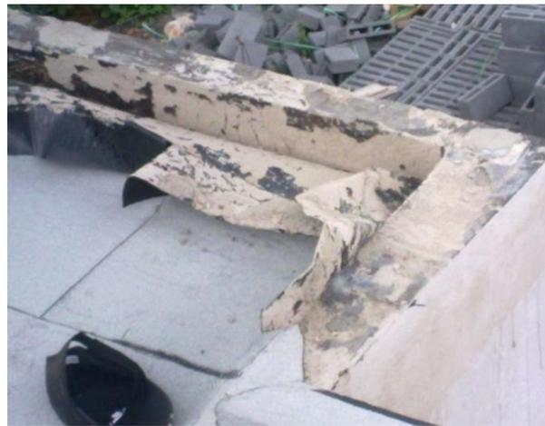
Fig.74. Desprendimiento de impermeabilizante. Fig. 75. Losa de azotea con mala calidad en colocación de aplanados lo que provoca el desprendimiento del impermeabilizante
