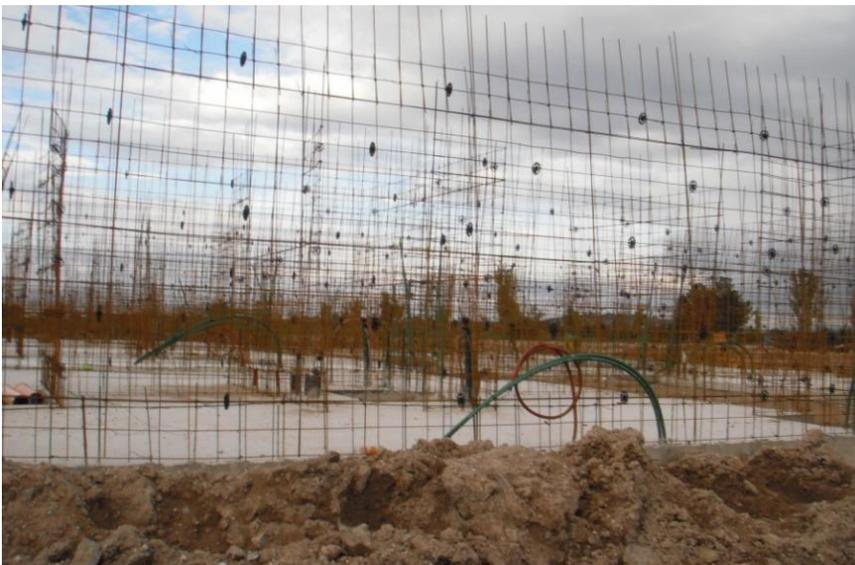
Fig. 35. Losa de cimentación y Armado estructural, preparada para colador de muros; vivienda prototipo castilla.
