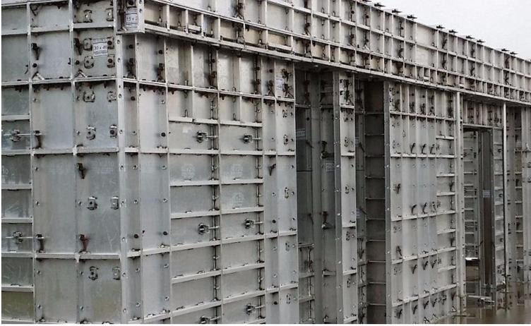
Fig. 36. Vista de la cimbra monolítica de aluminio utilizada para colar las viviendas (castilla) y Toledo.
