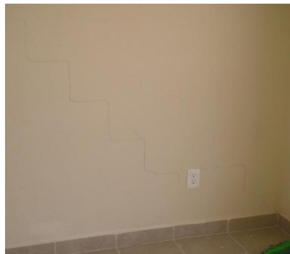
Fig.64. Fisura en muro de recámara
