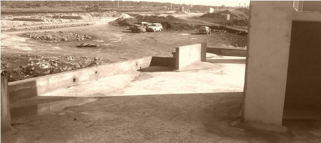
Fig.73. Vivienda en albañilería, con problema de encharcamiento.
