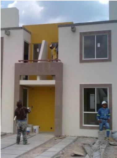
Fig.113. Aplicación de pasta en exterior Toledo
