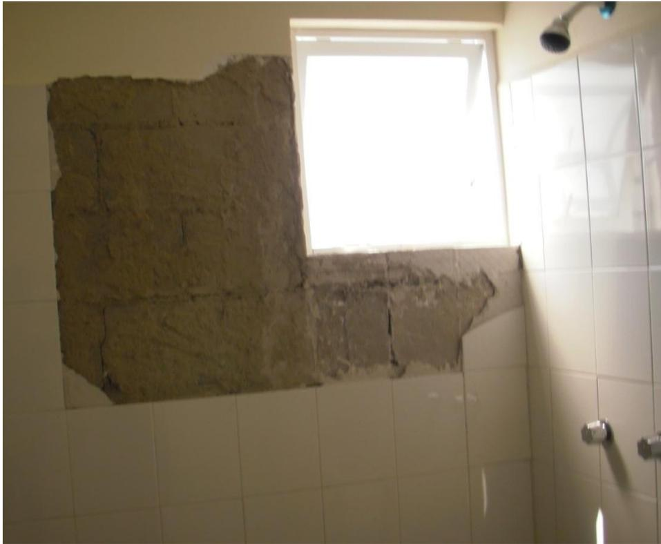
Fig.62. Fisura en muro de baño que provocó que el azulejo de baño se botara. Etapa 2.
