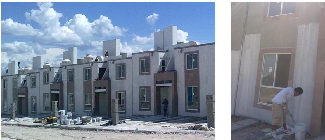
Fig.104 – Fig.105. Fondeo de fachadas exteriores prototipo Toledo.
