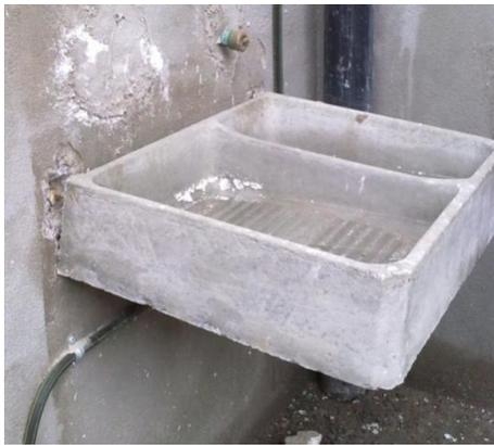
Fig.108. Lavadero caído, retirado y recolocado.
