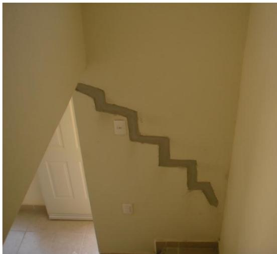
Fig.63. Fisuras reparadas en escalera.
