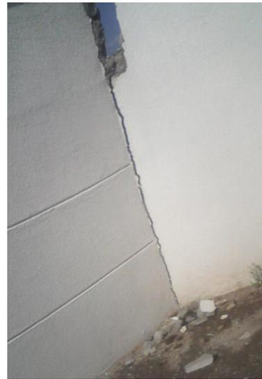
Fig.60. Fisuras en recámara PB. Toledo. Etapa 2
