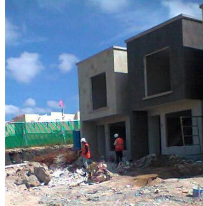
Fig.160. Viviendas en albañilerías y colocación de yesos al interior.
