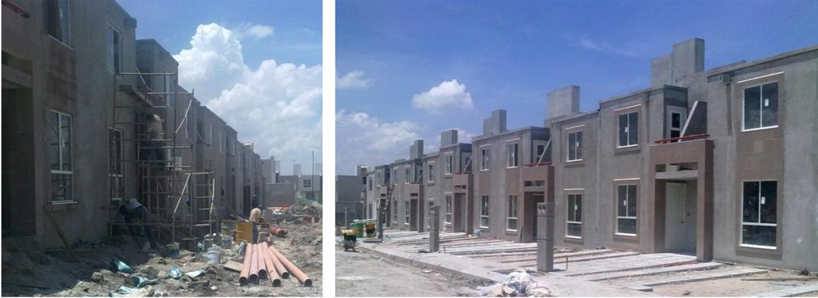
Fig.92 y Fig.93. Colocación de cantera en fachadas principales. Prototipo Valencia y Toledo.
