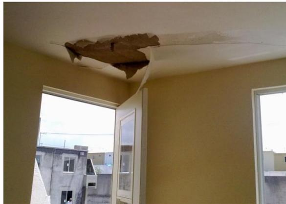
Fig.81 Desprendimiento de yeso en losa de entepiso.
