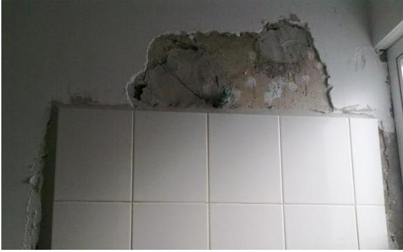
Fig.78. Oquedad en muro de baño.
