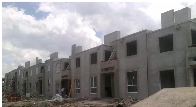
Fig.88 Colocación de ventanas
