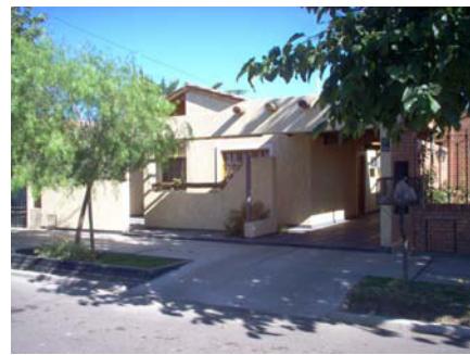
Fotografías 4.13 - Ejemplo de las Intervenciones en fachada
