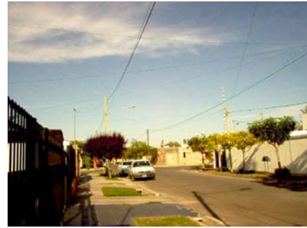
Fotografía 4.23 - Columna de alumbrado público y cableado aéreo
