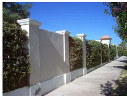
Fotografía 4.6 -Barda perimetral Casa Grande
