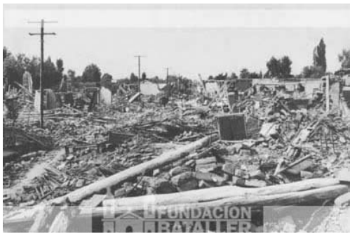
Fotografía 3.6 – Imagen de la destrucción
