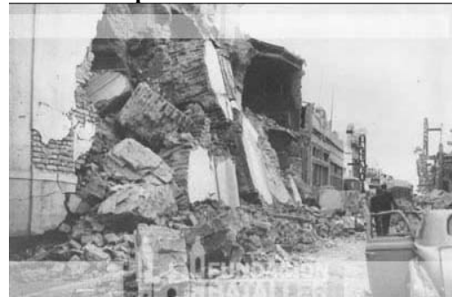
Fotografía 3.7 – Centro de la ciudad después del terremoto
