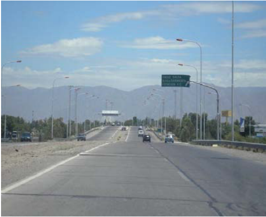
Fotografía 4.3 – Avenida de Circunvalación
