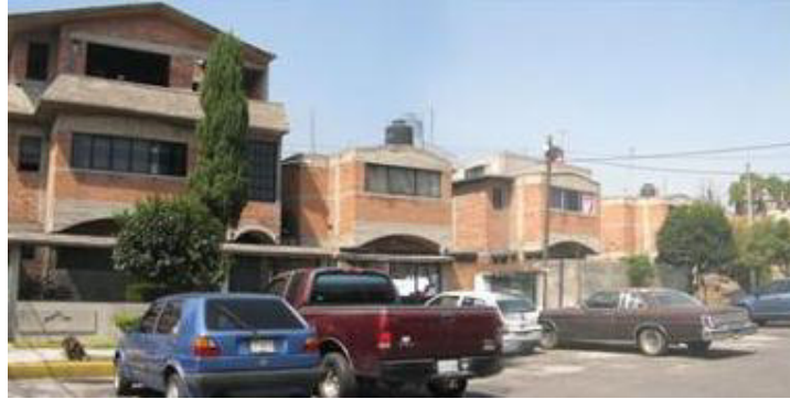
Imagen 6.14. Viviendas con ampliación en Ce Cualli Othli
