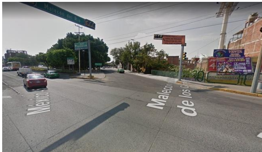
[Fotografía de Google Maps 2018] La intersección presenta continuamente trabajos de reparación vial.
