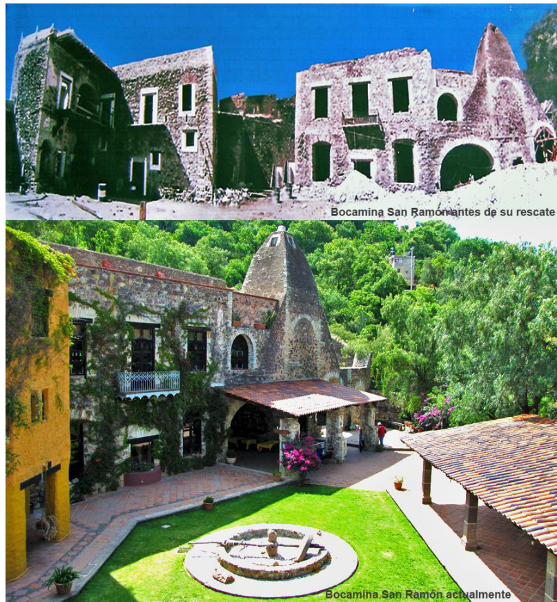
FIGURA 70: BOCAMINA DE SAN RAMÓN.
