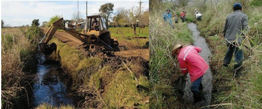
Figura 6. Desazolve y limpieza de canales.
