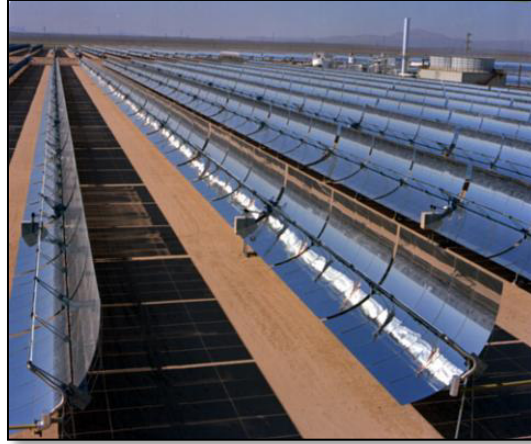
Fig. 1 Colector solar alta temperatura.
