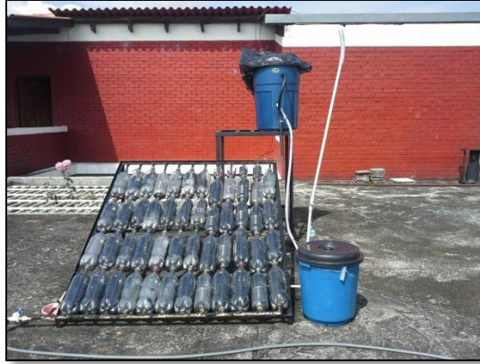
Fig. 5 colector solar con botellas PET
