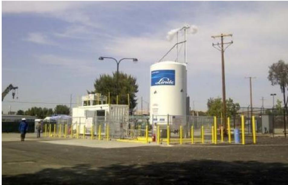
Figura 2. Sistema experimental de llenado para recipientes criogénicos con hidrógeno líquido.
