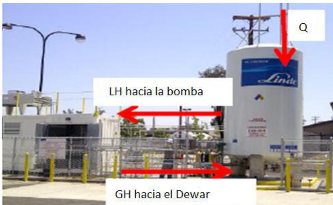
Figura 12. *Dewar* y bomba de hidrógeno líquido en el sistema experimental.
