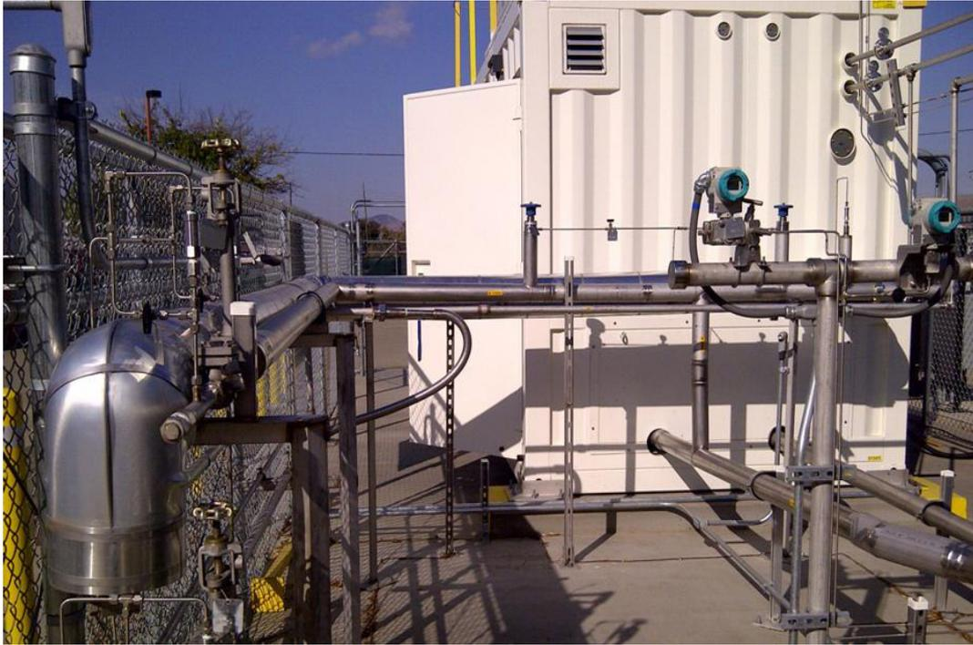
Figura 17. Sistema de tuberías para el hidrógeno líquido y gas criogénico.
