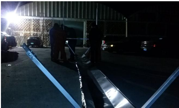
Figura 7. 15 Armado de la estructura de soporte del concentrador solar.
