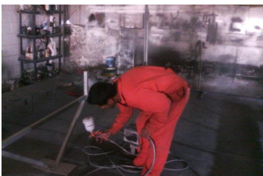
Figura 7. 3 Proceso de pintura de la estructura, parte central
