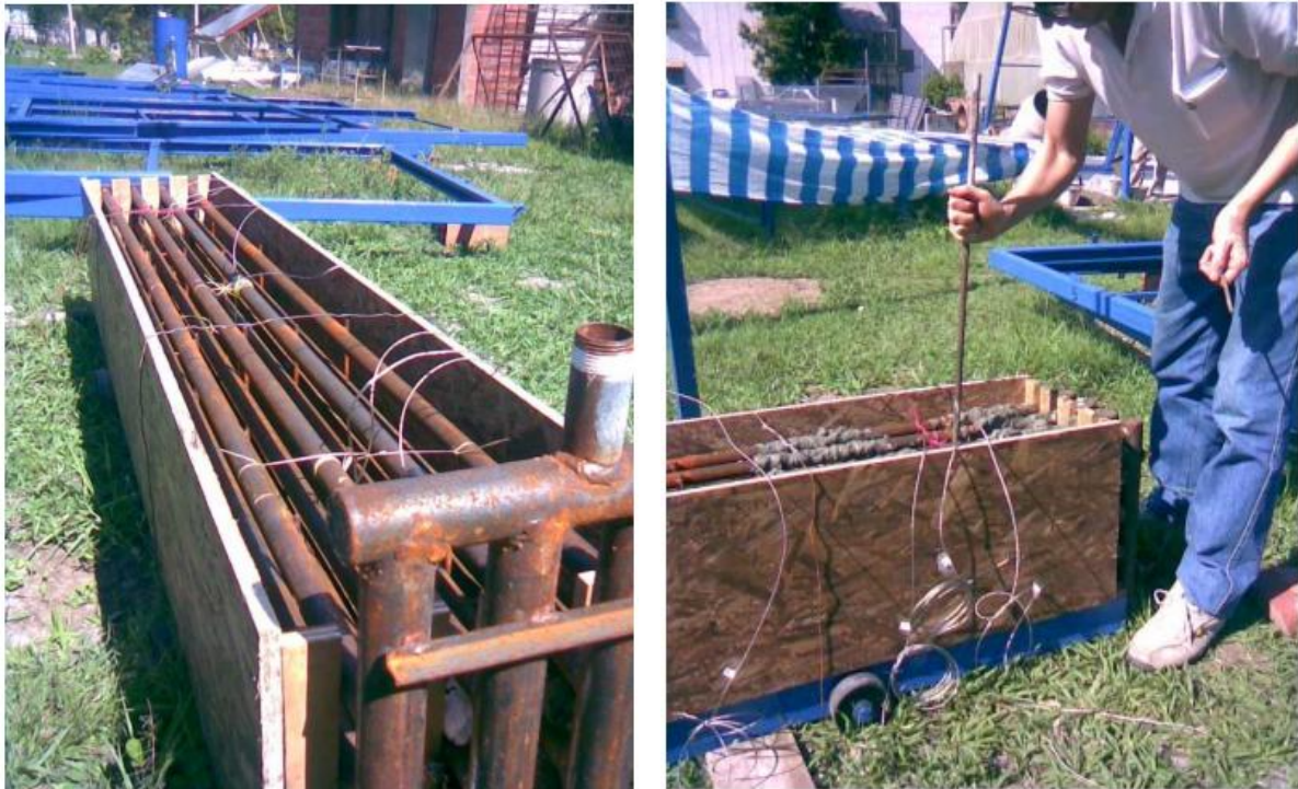
Figura 1. 16. Intercambiador de Calor y colado del hormigón [23].
