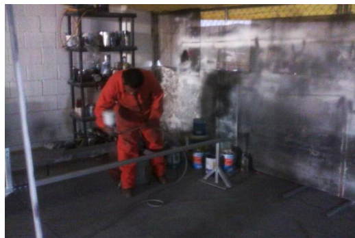
Figura 7. 2 Proceso de pintura de la estructura.
