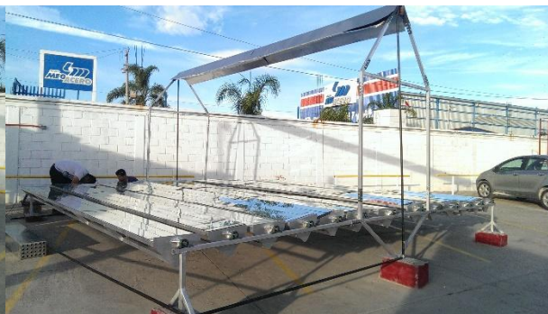
Figura 7. 22 Instalación del sistema PCM
