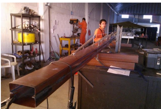
Figura 7. 9 Proceso de construcción de la estructura del concentrador solar.
