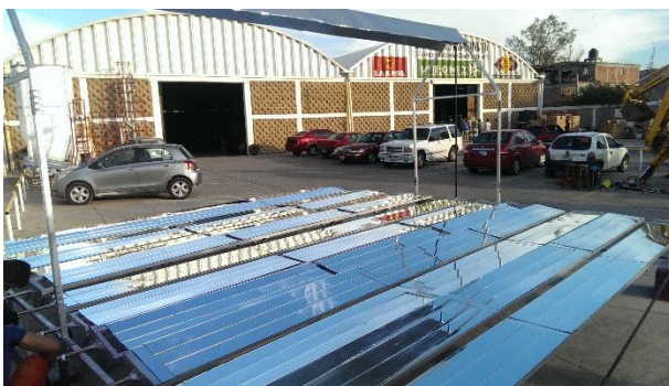
Figura 7. 19 Instalación de superficie reflectora y sistemas de rodamiento.
