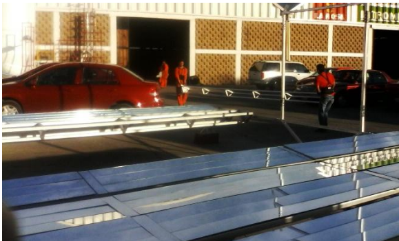
Figura 7. 17 Instalación de estructura de reflectores.
