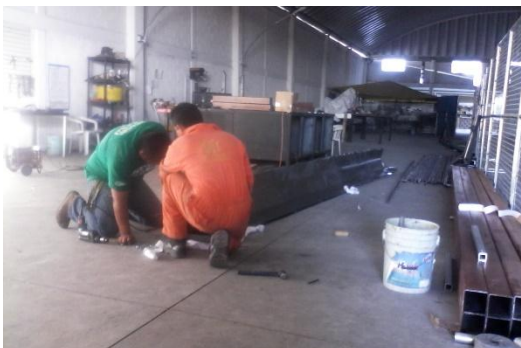
Figura 7. 1 Construcción del equipo en taller.
