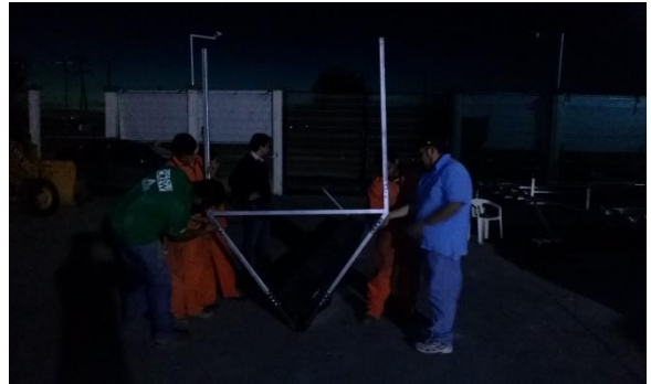
Figura 7. 14 Armado de la estructura de soporte del concentrador solar.
