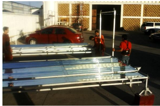
Figura 7. 18 Instalación de estructura de reflectores.
