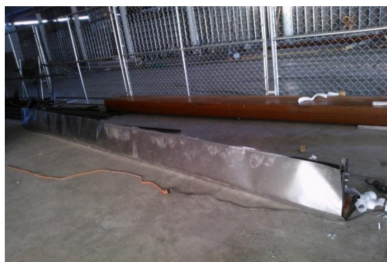
Figura 7. 10 Proceso de construcción de la estructura del concentrador solar.
