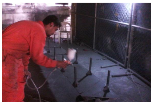
Figura 7. 4 Proceso de pintura de los soportes de los reflectores
