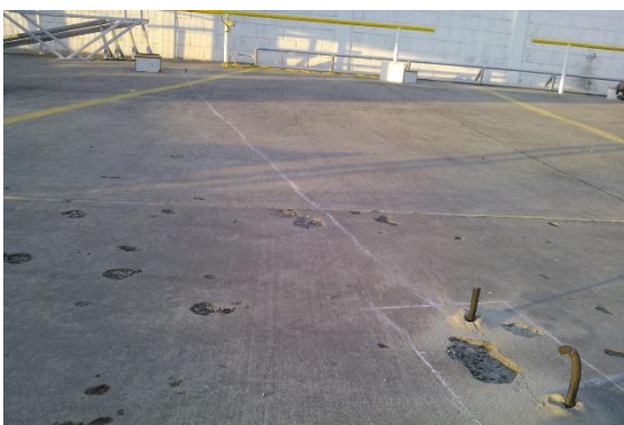
Figura 7. 11 Preparación de la superficie para la instalación del equipo
