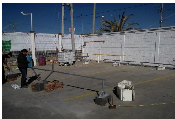
Figura 7. 12 Instalación de estructura base sobre dados de concreto.
