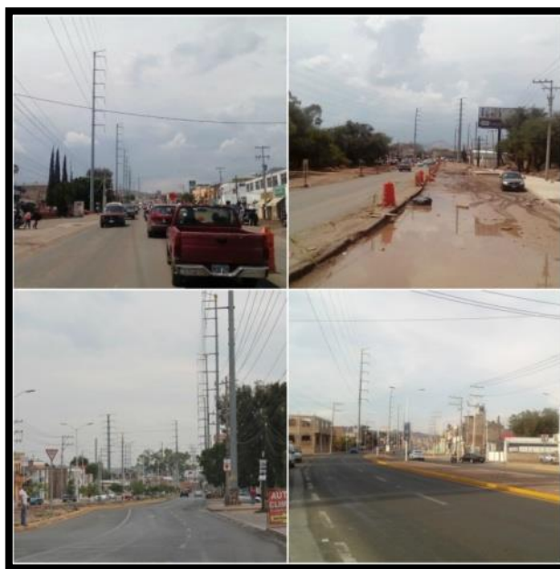
IMAGEN 5.1 CAMINO A PUENTECILLAS ANTES Y AHORA
