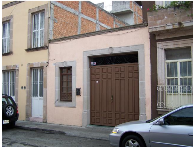
Imagen 68. Edificación del siglo XXI en sustitución de monumento histórico catalogado por el INAH, ubicado en Fernández de Córdoba No. 46
