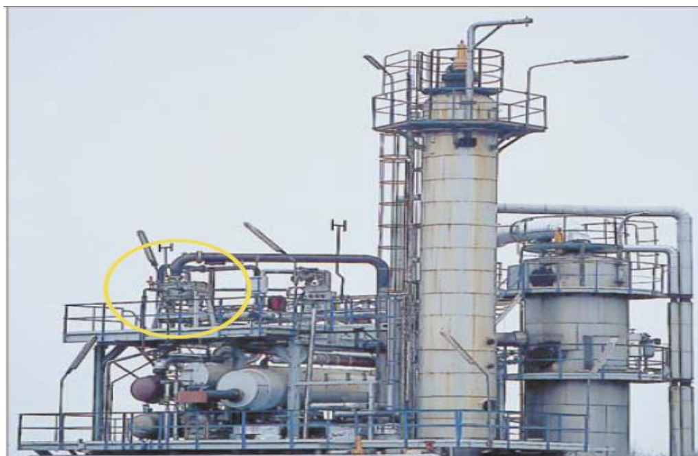
Figura 2.10. Compabloc ubicado en la parte alta de la torre de destilación [28].
