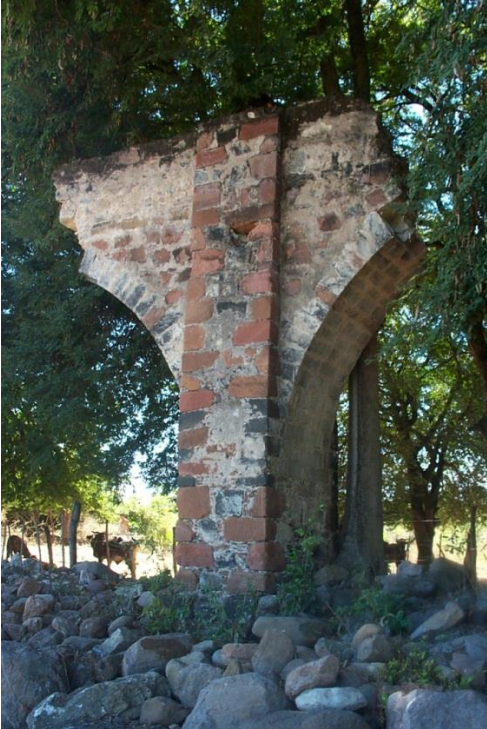
Fig. 7 Restos del acueducto que se conectaba con el molino del trapiche, antigua Hacienda La Zanja. Foto: A. Aguirre.
