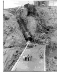
Construcción Puente-sifón Barranca Honda
