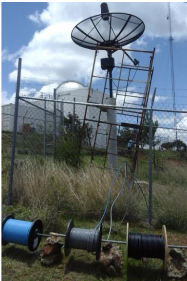
IMAGEN 6: Conexiones entre las antenas y el observatorio astronómico
