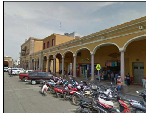
Ilustración 73. Análisis dimensional, calle Leona Vicario. Google Street view hacia el Oeste. relación altura media construida con la altura del portal
