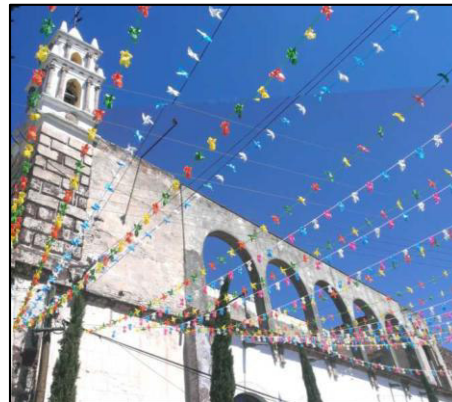
Ilustración 33. Adecuación de arquería en fachada principal
