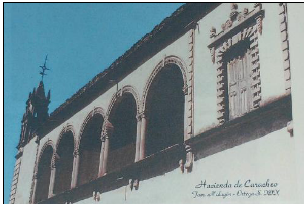
Ilustración 32. Arquería y marcos de cantería de la planta alta antes de ser removidos.
