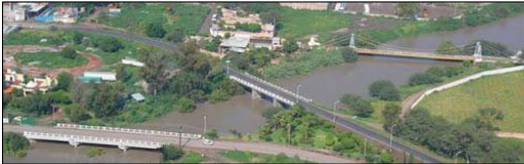
Ilustración 158. Derecha puente colgante 1922, al Centro Puente 1960, a la izquierda puente 1990.
