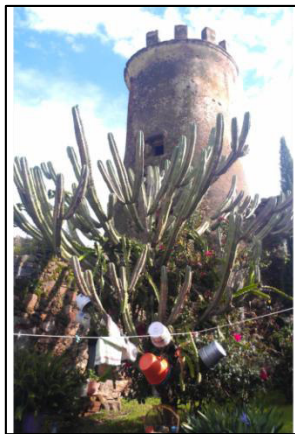
Ilustración 17. Torre norte del casco de la Hacienda de la Gavia.
