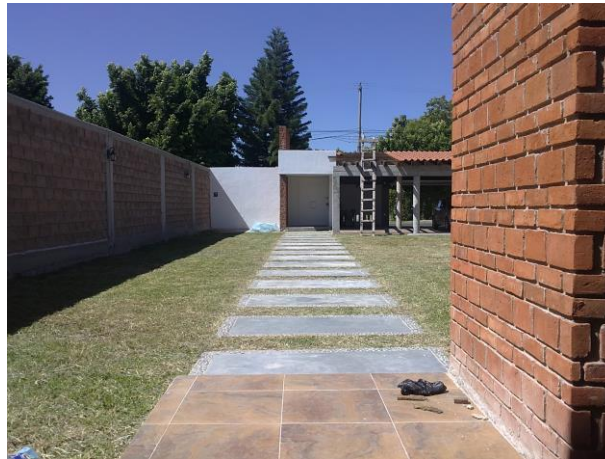
Vista Hacia Cochera 1
