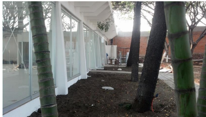
Rehabilitación de Edificio 1
