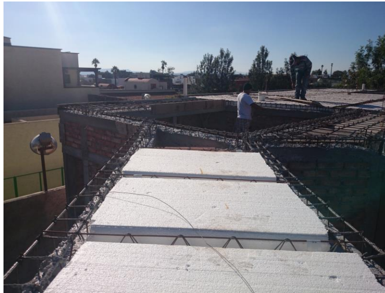
Losas y Estructura 1
