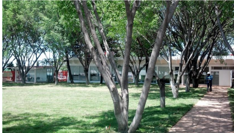
Rehabilitación de Edificio 2
