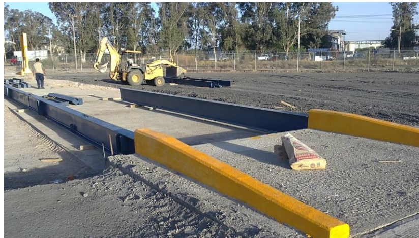
Construcción de Bascula 1
