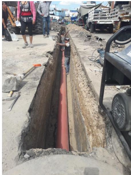
Tendido de tubería 1
