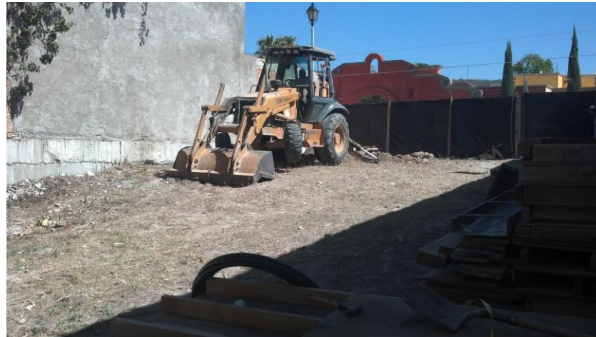
Preliminares de Obra 1
