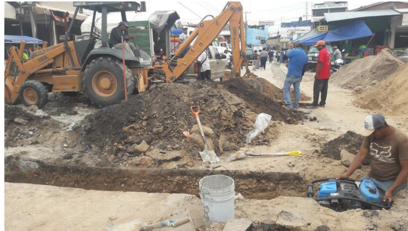
Excavación y Rellenos 1
