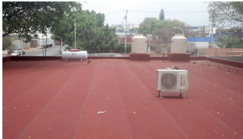
Impermeabilización de Azoteas 1
