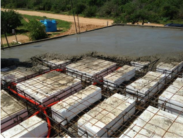
IMAGEN 7: Sistema de losa Nervada o aligerada.
