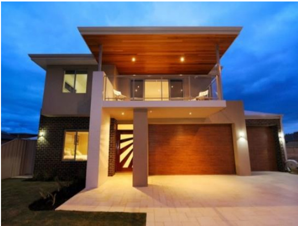
IMAGEN 2: Ejemplo de Losa que convencionalmente no podría ser calculada por método de análisis del Código ACI.
