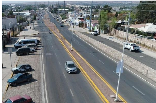
IMAGEN 50 VISTA CARRETERA A PUENTE DE CILLAS
