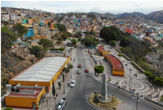
IMAGEN 54 VISTA PARADERO EN EX ESTACIÓN DEL FERROCARRIL
