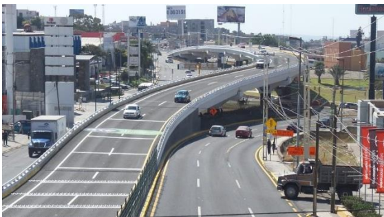
IMAGEN 49 VISTA PASO A DESNIVEL EN GLORIETA SANTA FE
