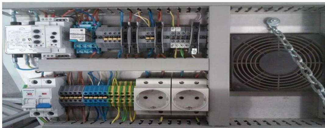
Figura 19. Circuito de alimentacion del ETB.
