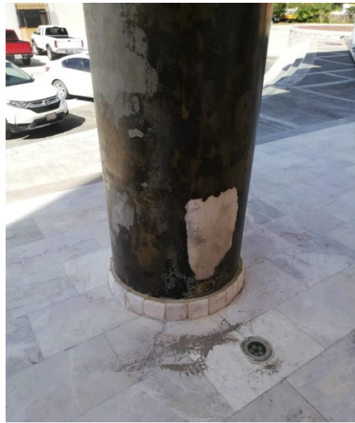
44. columnas de carga (Autoría: Propia, 2020)
