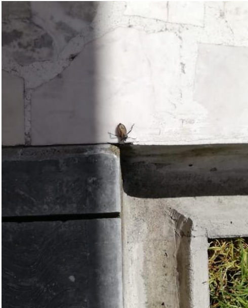
43. canales de agua (Autoría: Propia, 2020)
