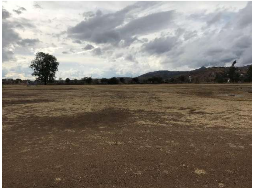
Ilustración 54. Vista del predio, se contempla el terreno a construir. Elaboración propia.
