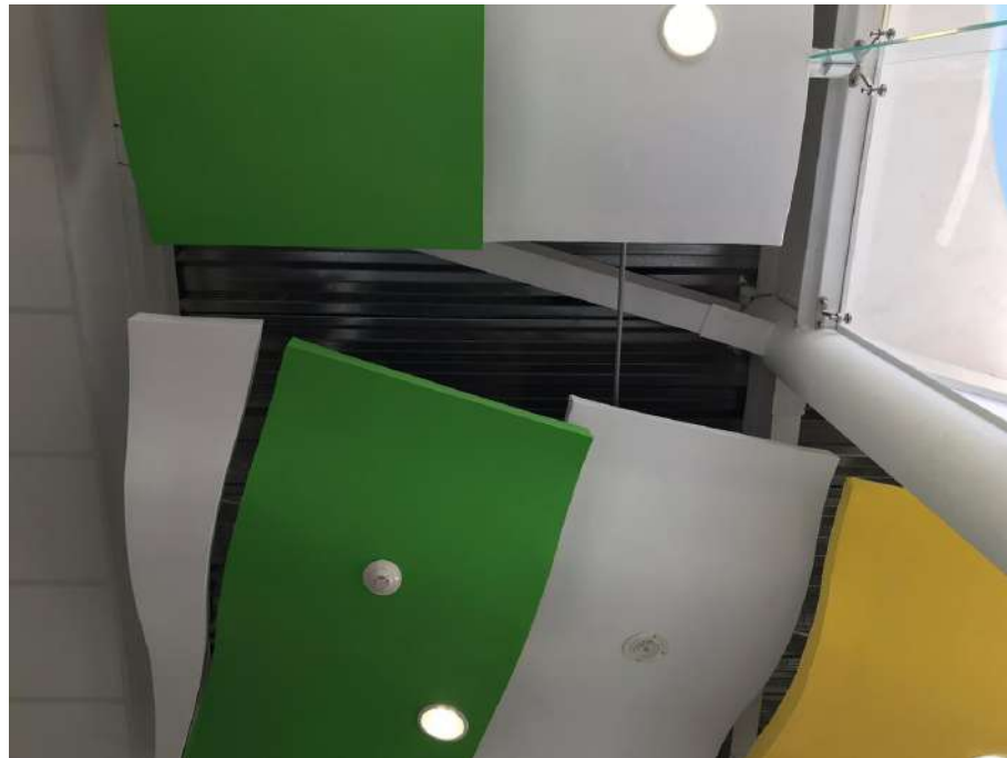
Ilustración 10. Estructura de acero y empleo de plafón, INGUDIS. Elaboración propia.
