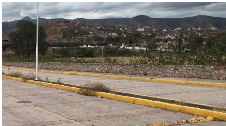
Ilustración 71. Límites artificiales: muro con cerca y vialidad principal al predio. Elaboración propia.
