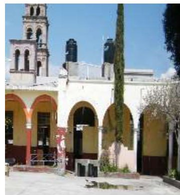
Zermeño Méndez, Salvador, se observa en la crujía sur las dos etapas al encontrarse las arcadas de tabique y de cantera, con la marquesina de concreto que será liberada, 2015-05 -16.
