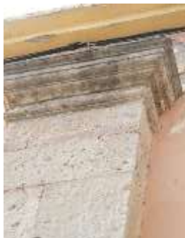
Zermeño Méndez, Salvador, exfoliaciones en la capa superficial de la cantera de fustes y capiteles, producto del intemperismo, en la calle de 5 de Mayo, 2015-05 -16.
