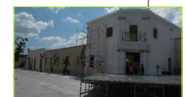
Muro de tabique rojo (Existente).
