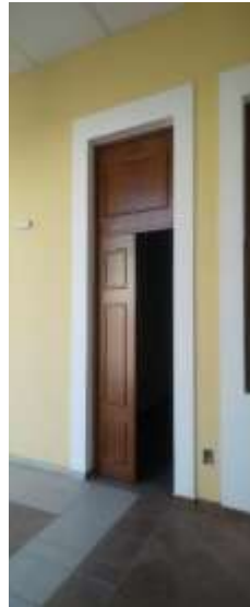
Zermeño Méndez, Salvador, puerta de madera de banack abatible C2 y C3, ubicadas en crujía oeste, 2016-01- 9.
