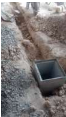
Zermeño Méndez, Salvador, En la imagen se ve la colocación de registro para red eléctrica, 2016-05 -11.
