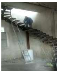
Zermeño Méndez, Salvador, ubicación de la nueva escalera que sustituye la escalera de caracol, para subir a oficinas y en la parte baja va a ir el SITE, 2016-09-13.
