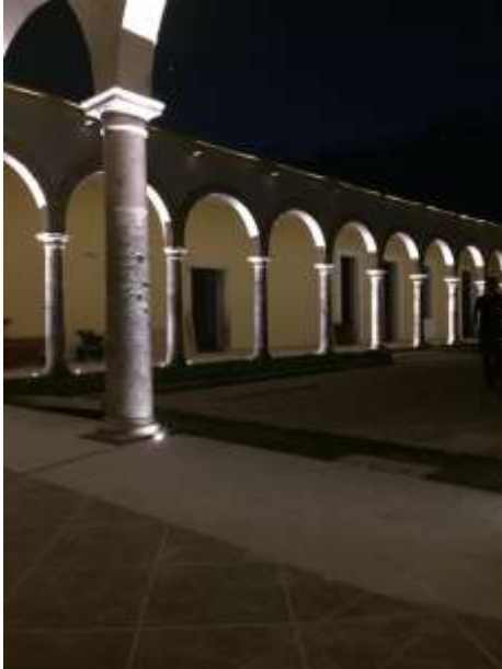
Zermeno Méndez, Salvador, patio central recién restaurado, donde se ubica la crujía sur de la arcada de cantera, prueba de iluminación 2016-12 -15.
