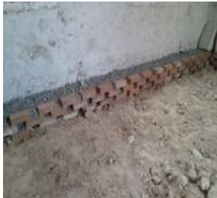
Zermeño Méndez, Salvador, se observa la capa tepetate y la capa de grava en el perímetro; el primero para recibir el firme y la grava en el perímetro para que el suelo respire y la humedad ascendente por capilaridad no llegue a los muros, en la cruja sur en lo que comprenderá la sala 3 de la colección de Hermenegildo Bustos, 2016-05-18.
