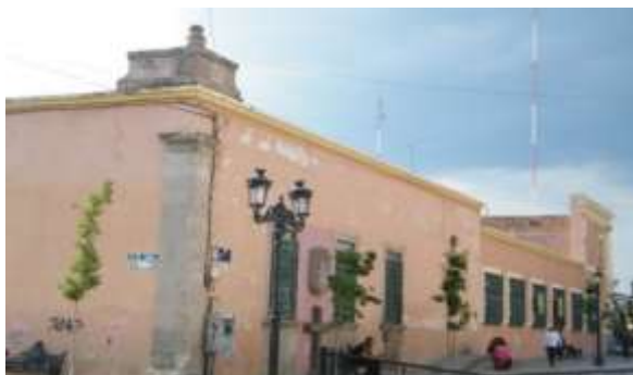
Zemeño Méndez, Salvador, Fachada en esquina de 5 de Mayo con calle Hermenegildo Bustos, 2015-05 -16.
