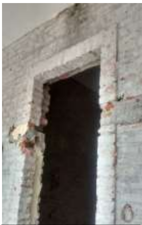
Zermeño Méndez, Salvador, se observa liberación de trabe de concreto en acceso la crujía sur, en la sala de la colección Hermenegildo Bustos 3, 2016-04-22.
