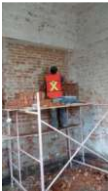
Zermeño Méndez, Salvador, Se completa muro de tabique en interior crujía que va a contemplar espacio lúdico, 2016-04 -11.
