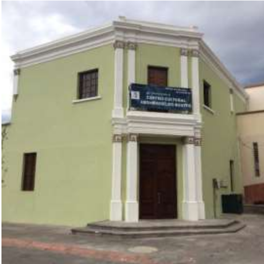
Zermeño Méndez, Salvador, Fachada en pancoupé recién restaurada, en el momento de la entrega de la obra al Instituto Estatal de la Cultura, 2017-01 -24.
