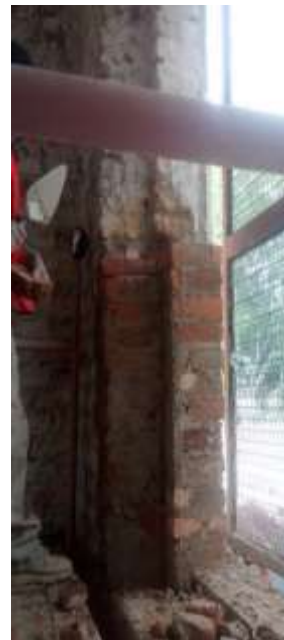
Zermeño Méndez, Salvador, se observa la reducción de vanos de ventanas verticales de la segunda etapa para abrir vanos verticales y a cada 3 hiladas se iba metiendo un tabique completo logrando el aparejo, 2016-05 -29.
