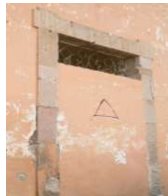
Zermeño Méndez, Salvador, detalle de vano tapeado de puerta principal de la primera etapa de la escuela en 1862, con marco de cantera la calle Hermenegildo Bustos, 2015-05 -16.
