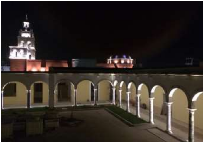
Zermeño Méndez, Salvador, patio central recién restaurado, donde se perciben las crujeas este y sur la arcada de columnas cantera, prueba de iluminación, 2016-12 -15.
