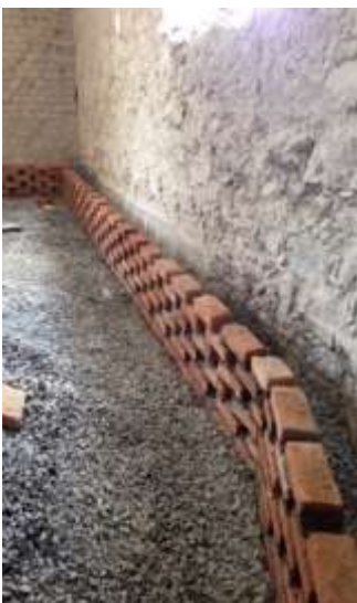
Zermeño Méndez, Salvador, se observa la excavación del suelo a 70 cm, colocando una capa de grava de ¾ y a su vez colocar un sistema de tabique de "Aparejo Palomero", de 7 hiladas, para generar un dren de 30 cm, en bodega taller de la crujía sur, 2016-04-18.
