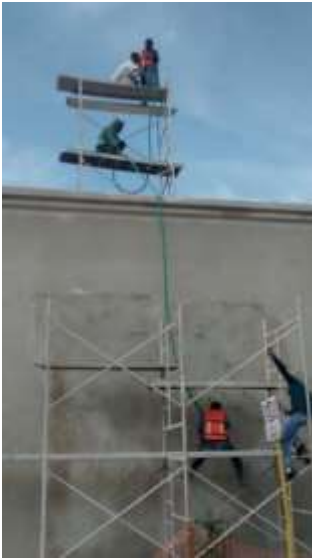
Zermeño Méndez, Salvador, se observa el procedimiento de la inyección de grietas en piedra a través de licuadora, previo cocido del muro, 2016-08 -11.
