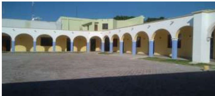
Zermeño Méndez, Salvador, patio principal, arcadas este y norte de tabique de 1939, imagen en el momento que se concluyó la primera etapa de restauración, 2017-01-9.
