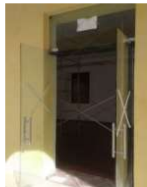
Zermeño Méndez, Salvador puerta en sala de exhibición 2, donde todos los elementos de aluminio para fijar las puertas y los cristales son marca Bruken. Los cristales son tipo templado de 10 mm de espesor. 2016-01-9.
