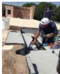
Zermeno Méndez, Salvador, se observa la colocación del impermeabilizante termofusionado, 2016-04-27.
