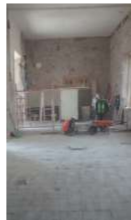
Zermeño Méndez, Salvador, En la imagen se ve la demolición de los baños de niñas en la crujía este adosada al zaguán de entrada de la primera etapa de la escuela, 2016-04 -18.
