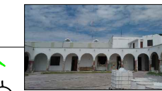
Aplanado de mortero de a base de cal apagada y arena, en muros de tabique rojo, a plomo y regleado, afinado con lana de madera. Muro de tabique rojo (Existente).
