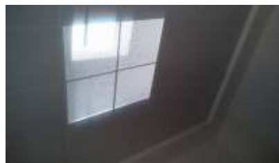
Zermeño Méndez, Salvador, se observa en la crujía oeste, en el espacio destinado para el taller de artes plásticas, el domo que quedó de policarbonato, liberando los domos de vitro block. 2017-01-9.
