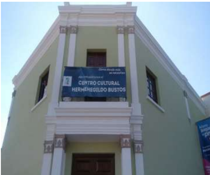
Zermeño Méndez, Salvador, Fachada en pancoupé recién restaurada, en el momento de la entrega de la obra al Instituto Estatal de la Cultura, 2017-01 -24.
