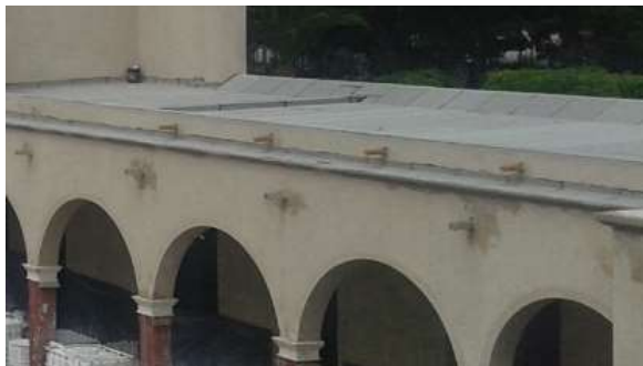
Zermeño Méndez, Salvador, se observa, como quedó el trazó de los arcos, dónde se colocaron reglas con duela de madera de pino cepillada y canteada, se buscó el punto de los arcos y se zarpea en tres capas de 2.5 cm de espesor, esperando 24 horas para que reviente la mezcla de cal, para luego dar el acabado fino como se ve, 2016-08-16.
