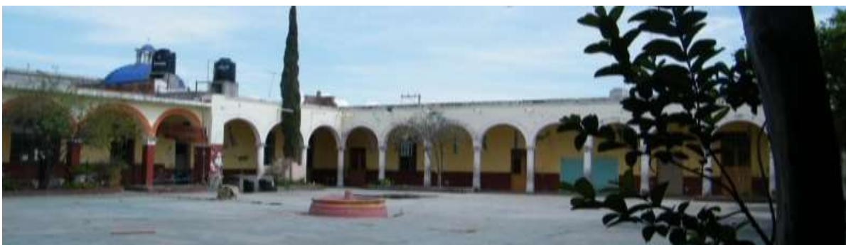
Zermeño Méndez, Salvador, patio central, en el pórtico sureste, se observa las arcadas de los pórticos perimetrales, marcando el corte de las dos historias constructivas con las columnas de cantera pintadas en rosa con pintura vinílica y las columnas de tabique en rojo, en el momento posterior a la desocupación de la escuela, se observa la existencia de árboles que fueron retirados con autorización de Parmues y Jarrines del municipio de Purísima 2015-05-16.
