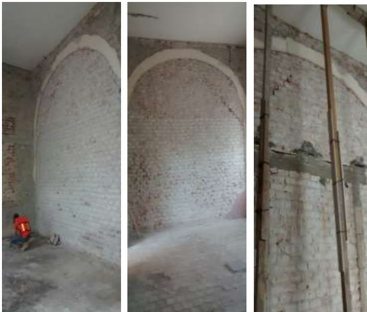
Zermeño Méndez, Salvador, En las dos primeras imágenes del 2016-04-08 se ve el arco de cantera que conformaba la abertura en la que se conectaba la crujía de la esquina sureste en las calles Hermenegildo Bustos y 5 de Mayo y que fue tapeado; pero por la necesidad de conectar la sala de exposición 4 y la sala de la colección Hermenegildo Bustos, fue necesario abrir un vano rectangular ubicando un marco rígido de concreto, posterior a la colocación de los IPR'S para evitar los esfuerzos cortantes de las bóvedas escarzanas, como se ve en la tercera imagen del 2016-08-18.
