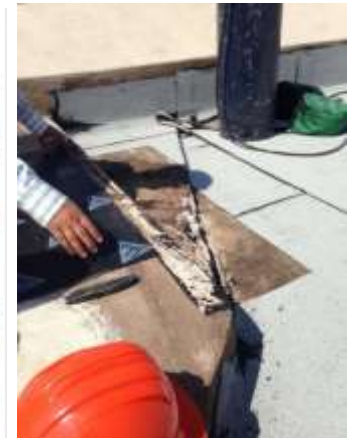
Zermeño Méndez, Salvador, se observa la colocación de la carpeta asfáltica termofusionada Sika o Chovatec autorizada por el INAH, 2016-04-
