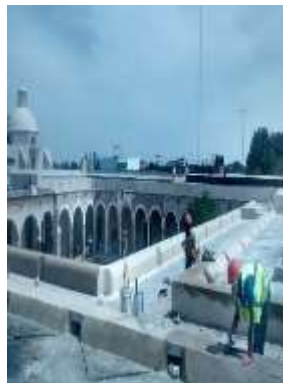
Zermeño Méndez, Salvador, En las 4 imágenes se observa la colocación de la carpeta asfáltica termofusionada Sika o Chovetec autorizada por el INAH, 2016-04-29,
