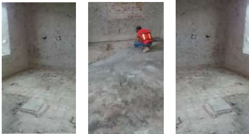
Zermeño Méndez, Salvador, en las tres imágenes se observa la recuperación del piso de barro de las 3 crujías ubicadas en el sureste de la etapa de 1868, contiguas al zaguán de acceso; procediéndose a demoler el piso de mosaico que estaba pegado con cemento arena, con cuidado y a golpe rasante; limpiándose cada pieza; por lo que en la primera crujía norte se recupera en un 85 % completándose con el piso de barro de la tercera crujía, que el INAH autorizó; en la crujía poniente contigua a la norte se recupera en su totalidad. 2016-04-08
