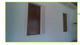
Muro de Piedra braza (Existente, espesor 0.70 M-1.00 M).
