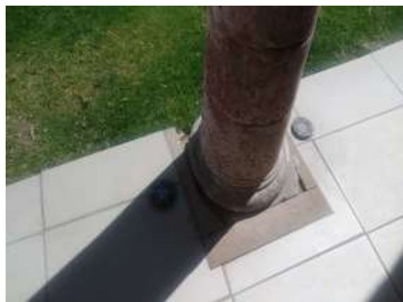
Zermeño Méndez, Salvador, se observa como quedó la base de la columna bordeada por una cenefa de piedra y las lámparas de iluminación, quitando las jardineras en la crujía oeste, 2017-01-19
