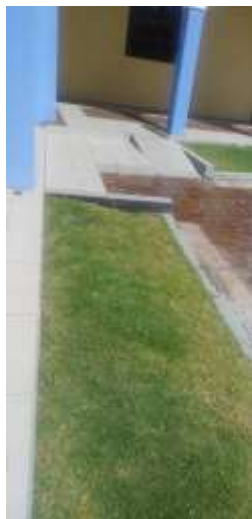
Zermeño Méndez, Salvador, en las dos imágenes se observa la sustitución de las jardineras por unos taludes de pasto y una cenefa de cantera, con orificios para captación de agua, donde está el colector de aguas pluviales en todo el patio central; así como las escalinatas y rampas para discapacitados, 2017-01-19.
