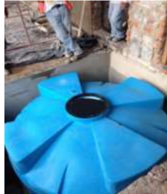
Zermeño Méndez, Salvador, En las tres imágenes se observa cómo se suministró y colocó la cisterna de 10,000 litros marca Rotoplas, que incluyó en su proceso; trazo y nivelación, así como la demolición del muro de 2.35 m x 1.50 m de 35 cm de espesor, retirando el material producto de la demolición fuera de la obra. A su vez la excavación se hizo con medios manuales de la fosa séptica, para colocar la cisterna a una profundidad de 3.50 profundidad; con un ancho de 2.8 m x 2.8 m de ancho, 2016-06 -27.
