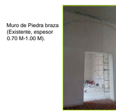
Aplanado de mortero de a base de cal apagada y arena, en muros de tabique rojo, a plomo y regleado, afinado con lana de madera.
