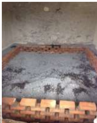
Zermeño Méndez, Salvador, se observa la colocación del tabique de "Aparejo Palomero" de 7 hiladas, para generar un dren de 30 cm y la colocación de la grava antes de situar el tepetate, en lo que va a conformar la tercera sala de exposición permanente, 2016-04-14.
