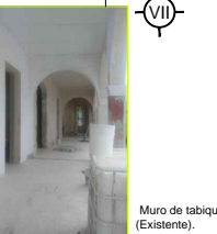
Muro de tabique rojo (Existente).
