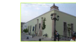
Pintura a la cal, preparada agregando a la mezcla sal previamente disuelta en agua, caseína, alumbre, en colores aceptados por el INAH, con pigmentos naturales, aplicado con brocha de cerdas naturales a cinco manos.
