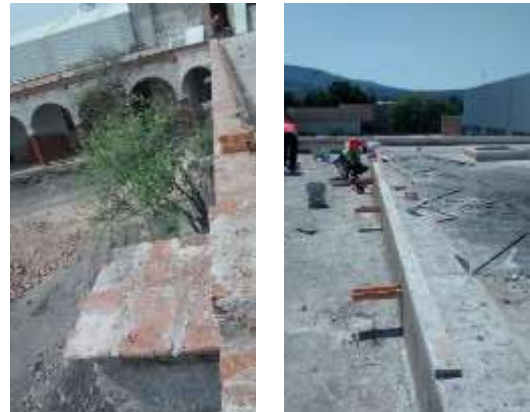
Zermeno Méndez, Salvador, en las dos imágenes se observa el estado en que se encontraba la azotea en el que fue removido el impermeabilizante anterior que se encontraba en mal estado y que se colocó sobre la zotehuela, 2016-04-18.
