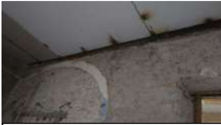
Zermeño Méndez, Salvador, en las dos imágenes se observa la colocación de vigas IPR's, su empotre arriba del arco de medio punto, para recibir los IPR's de las bóvedas escarzanas existentes, 2016-09-20.
