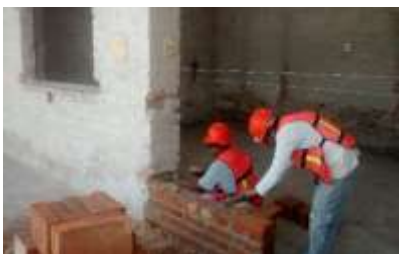
Zermeño Méndez, Salvador, en las dos imágenes se ve la reducción del vano en lo que va a conformar el taller de artes plásticas, para modular una puerta vertical, como está el módulo de las puertas de la primera y segunda etapa, aparejando el tabique en la ampliación del muro para la reducción del vano, 2016-05 -27.
