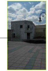
Muro de tabique rojo (Existente).
