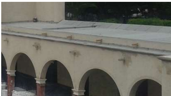
Zermeño Méndez, Salvador, se observan las gárgolas de barro moduladas arriba de cada fuste de cada arco, 2016-08-16.
