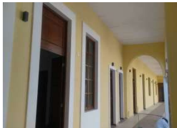
Zermeño Méndez, Salvador, puerta de madera de banack abatible C5 y ventana de madera, ubicadas en crujía oeste, 2016-01- 9.
