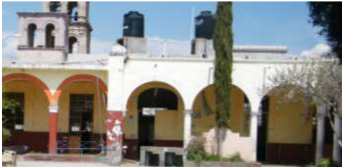
Zermeño Méndez, Salvador, pórticos de tabique y cantera que marcan las dos etapas constructivas, de 1862 y 1939, proceso posterior a la desocupación de la escuela, se observa la existencia de árboles, bebederos, lavaderos, tinacos, tuberías, marquesina, escusados y lavabos, que fueron retirados, 2015-05 -16.
