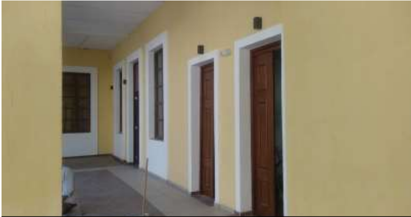
Zermeño Méndez, Salvador, patio central recién restaurado, se observa el pórtico perimetral sur, aun esperando la restauración de la segunda etapa en columnas de cantera, 2017-01 -24.
