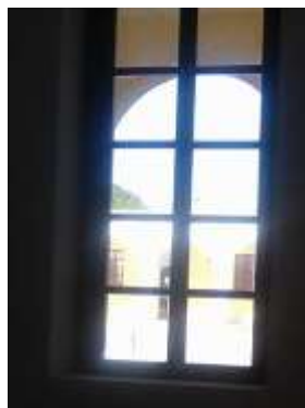
Zermeño Méndez, Salvador, ventana de madera de banack abatible V-01 ubicadas en crujía oeste, 2016-01- 9.
