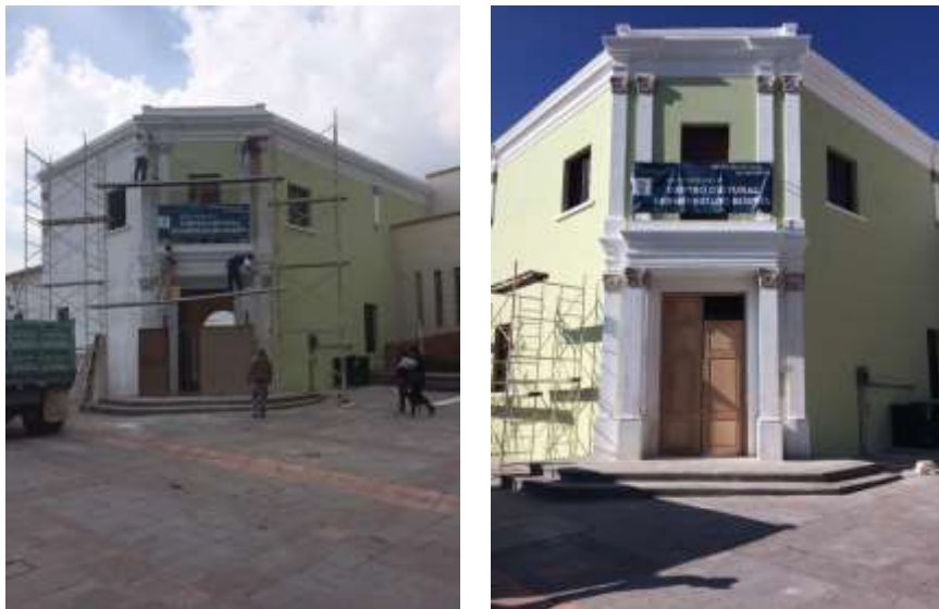
Zermeño Méndez, Salvador, En las dos imágenes se ve el proceso de la colocación de la pintura a la cal, 2016-11 -14 y 2016-11-21, respectivamente.
