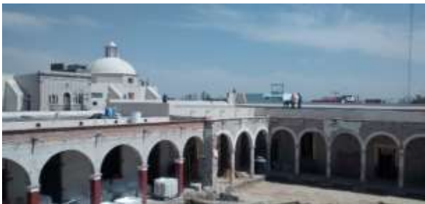
Zermeño Méndez, Salvador, patio principal, arcada este en la que se ve el corte histórico de 1862 y 1939, se ve el proceso de retiro de aplanados y la nivelación del patio en un mismo nivel , 2016-04-19.
