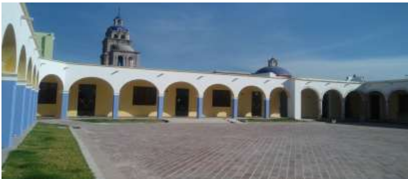
Zermeño Méndez, Salvador, patio central recién restaurado, se observa el pórtico perimetral este, donde se observan con claridad las dos etapas constructivas: 1862- 1939, 2017-01 -24.
