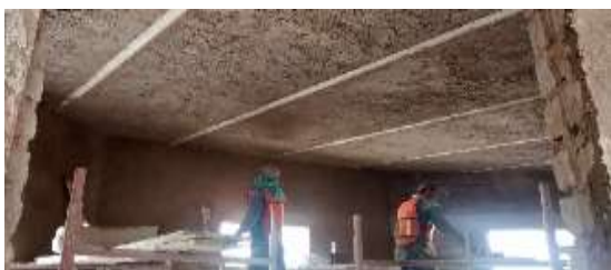
Zermeño Méndez, Salvador, patio principal, arcada este en la que se ve el corte histórico de 1862 y 1939, se ve el proceso de retiro de aplanados y la nivelación del patio en un mismo nivel , 2016-04-19.
