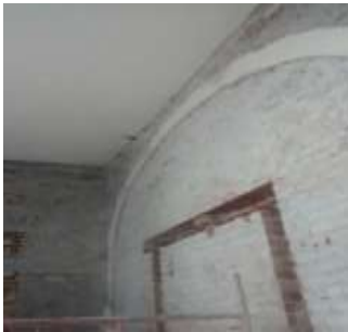
Zermeño Méndez, Salvador, se observa la sala de exposición temporal en la esquina de la crujía este y en ella el arco de piezas de cantera, tapeado con tabique, al cual se le colocó un marco rígido de concreto, para lograr la continuidad espacial con la sala dedicada a la obra de Hermenegildo Bustos, 2016-08-11.
