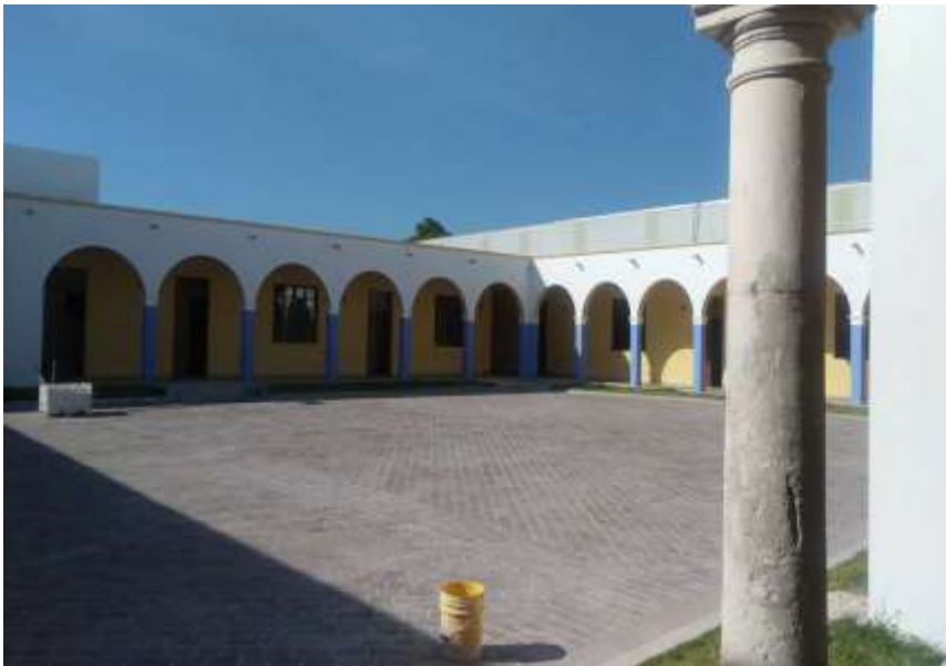
Zermeño Méndez, Salvador, patio central recién restaurado, donde se ubica la crujía noroeste de la arcada de tabique, 2017-01 -24.
