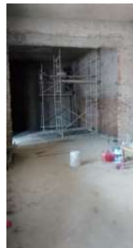
Zermeño Méndez, Salvador, se observa la liberación del muro eliminado en el eje AC, de la crujía norte, donde se va a ubicar el salón de usos múltiples, 2017-01-19.
