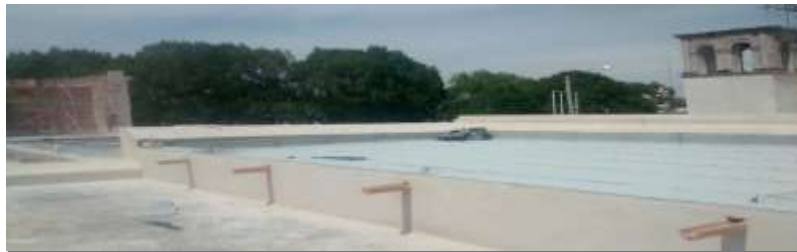
Zermeño Méndez, Salvador, se observa la colocación de la carpeta asfáltica termofusionada Sika autorizada por el INAH, 2016-04-29,
