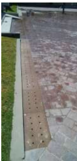
Zermeño Méndez, Salvador, en las dos imágenes se observa la sustitución de las jardineras por unos taludes de pasto y una cenefa de cantera, con orificios para captación de agua, donde está el colector de aguas pluviales en todo el patio central; así como las escalinatas y rampas para discapacitados, 2017-01-19.
