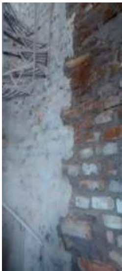
Zermeño Méndez, Salvador, tapeado de ventana en espacio para recepción y SITE y a cada 3 hiladas se iba metiendo un tabique completo logrando el aparejo tanto en reducción de vanos de la fachada principal como en el cierre de vanos del lugar donde se encontraba la escalera, 2016-04 -29.
