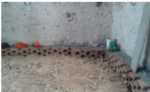
Zermeño Méndez, Salvador, se observa la capa tepetate y la capa de grava en el perímetro; el primero para recibir el firme y la grava en el perímetro para que el suelo respire y la humedad ascendente por capilaridad no llegue a los muros, en la crujía sur en lo que comprenderá el área lúdica, 2016-05-18
