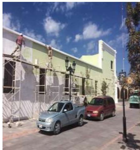
Zermeño Méndez, Salvador, Zermeño Méndez, Salvador, Las ventanas de la escuela de 1939 eran vanos cuadrados de 2.10 m x 2.10 m, en la fachada en Hermenegildo Bustos, cambiando los módulos de los vanos de modo vertical, siguiendo el patrón de diseño de los vanos de la primera escuela de 1868, de 1.10 de ancho por 2.10 m, además de la colocación de la pintura a la cal, 2016-08 -11.
