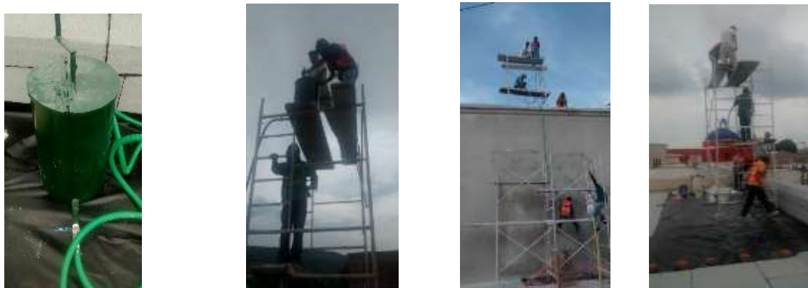
Zermeño Méndez, Salvador, En todas las imágenes se observa el procedimiento para la inyección de grietas en piedra a través de licuadora: 1. Limpiándose previamente con compresor de aire la grieta, con el fin de quitar todas las rajuelas de piedra sueltas, por la degradación del mortero de cal apagada; 2. Incorporando agua de la grieta; 3. Uso de licuadora, a 8 metros y medio de alto, colocando dos andamios metálicos; 4. Colocación de mangueras a cada 30 cm mangueras de 1" de poliducto naranja. 5. Cocimiento del muro con rajuela de piedra el muro rajueleandolo, para que sirviera de cimbra en el momento en que se hizo la inyección y 6. Inyección con licuadora de grietas, además de los materiales como caseína, grout, cero grano de mármol, cal apagada y acetato de polivinilo. Las imágenes de limpieza y preparación de la grieta A, son del 2016-06 -29 al 2016-08 -13; las imágenes de los materiales empleados B, son del 2016-06 -29 y la de la inyección de licuadora C, fueron tomadas el 2016-06 -29.
