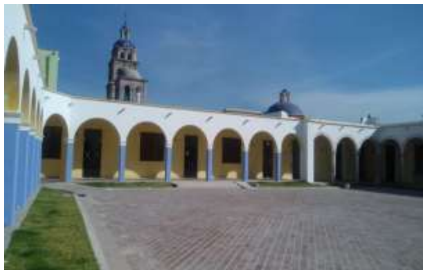
Zemeño Méndez, Salvador, patio principal, arcada este en la que se ve el corte histórico de 1862 y 1939, por el cambio de las columnas de cantera a tabique, 2017-01-24
