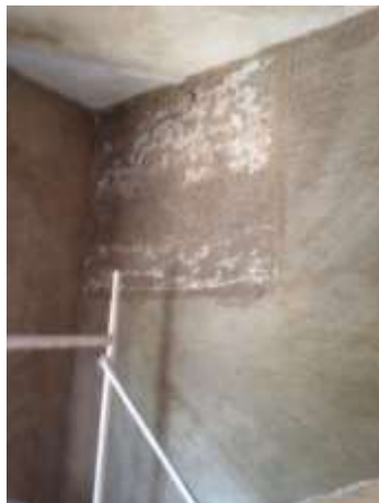
Zermeño Méndez, Salvador, en las dos imágenes se observa el tratamiento que se le dio a las grietas en tabique, empezando por eliminar polvo y aplicando agua a presión para lavar la grieta, colocar una cercha y desarrollar la inyección, 2016-05-18.
