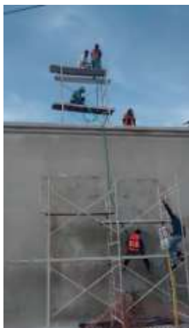
Zermeño Méndez, Salvador, inyección de grietas por medio de licuadora en el muro de piedra, por medio de licuadora, 2016-08 -30.
