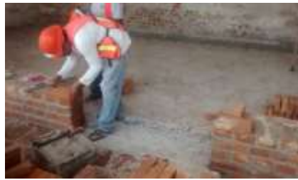
Zermeño Méndez, Salvador, en las dos imágenes se ve la reducción del vano en lo que va a conformar el taller de artes plásticas, para modular una puerta vertical, como está el módulo de las puertas de la primera y segunda etapa, aparejando el tabique en la ampliación del muro para la reducción del vano, 2016-05 -27.
