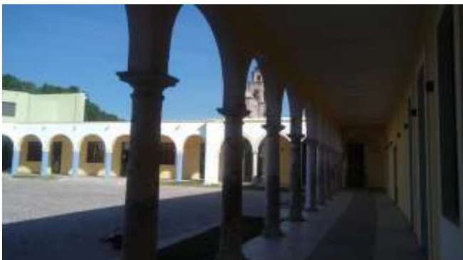
Zermeño Méndez, Salvador, se observa el patio central y la crujía sur en el momento de la entrega recepción de la primera etapa, 2017-01-9.
