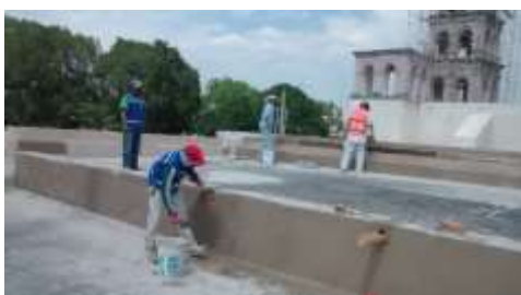
Zermeno Méndez, Salvador, se observa el forjado de pretiles a base de muro de ladrillo recocido de 14 cm. De espesor adherido con mortero cal apagada arena 1:3, 2016-04-27.
