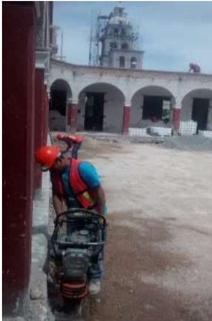
Zermeño Méndez, Salvador, el uso de bailarina en los arcos de tabique, equipo que no se usó en la arcada de cantera, dado que el rodillo iba primero de oriente a poniente y luego de norte a sur; la vibración fue pequeña, junto a las columnas de cantera al pasar el rodillo a través de un lento movimiento para evitar desplazamientos en los arcos de cantera 2016-04-29.
