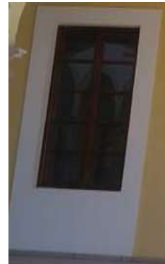
Zermeño Méndez, Salvador, ventana de madera de banack abatible V-02 ubicadas en crujía oeste, 2016-01- 9.
