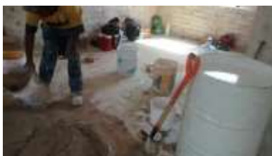
Zermeño Méndez, Salvador, se observa el tambor metálico donde se ubica la cal apagada, en el proceso previo para hacer la mezcla para los repellados en muros, 2016-04-18.
