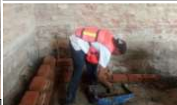
Zermeño Méndez, Salvador, se observa la colocación del tabique de "Aparejo Palomero" de 7 hiladas, para generar un dren de 30 cm, en bodega taller de la crujía oeste en lo que va a conformar el taller de artes plásticas, 2016-04-22.
