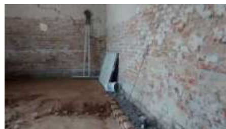
Zermeño Méndez, Salvador, se observa la capa tepetate y la capa de grava en el perímetro; el primero para recibir el firme y la grava en el perímetro para que el suelo respire y la humedad ascendente por capilaridad no llegue a los muros, en la crujía norte en lo que comprenderá el área lúdica, 2016-04-29.
