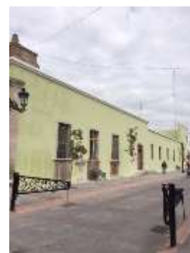
Zermeño Méndez, Salvador, se observa la integración de las dos fachadas al modular de modo vertical, siguiendo el patrón de diseño de los vanos de la primera escuela de 1868, de 1.10 de ancho por 2.10 m, en la fachada Hermenegildo Bustos, 2016-11 -18.
