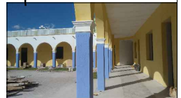
Pintura a la cal, preparada agregando a la mezcla sal previamente disuelta en agua, caseína, alumbre, en colores aceptados por el INAH, con pigmentos naturales, aplicado con brocha de cerdas naturales a cinco manos. Muro de tabique rojo (Existente).
