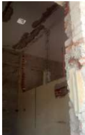
Zermeño Méndez, Salvador, se observa liberación de muro de tabique con castillos armados en la sala de la colección Hermenegildo Bustos 3, 2016-04-22.
