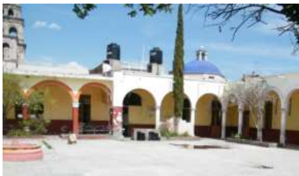
Zermeño Méndez, Salvador, se observa la marquesina que es una extensión de los IPR's y la bóveda de cuña escarzana, en el pórtico de arcos de tabique de la segunda etapa, a su vez la diferencia en alturas donde se ve el corte histórico de los dos momentos y los tinacos que de modo improvisado se ubican encima de los baños que están situados en lo que era el acceso y el zaguán de la primera etapa. 2015-05 -16
