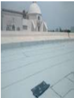
Zermeño Méndez, Salvador, En las 4 imágenes se observa la colocación de la carpeta asfáltica termofusionada Sika o Chovetec autorizada por el INAH, 2016-04-29,
