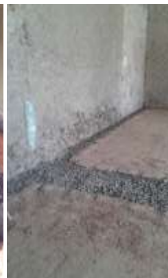
Zermeño Méndez, Salvador, se observa la colocación de la grava y el tepetate compactado, en lo que va a conformar la tercera sala de la colección de Hermenegildo Bustos, 2016-04-14.
