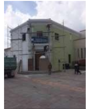
Zermeño Méndez, Salvador, en la imagen se observa la restauración de las molduras hechas de pasta de cal apagada con arena para la recuperación de las molduras se proceden a la fabricación de un molde en obra con jabón neutro moldeable. Teniendo listo el molde se puso una regla de madera y luego con una cierra se cortaba la moldura, para que los albañiles conformaran dicha moldura, 2016-06 - 10.
