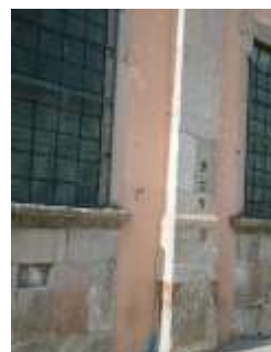
Zermeño Méndez, Salvador, exfoliaciones en la capa superficial y pérdida de piezas de cantera de bases de pilastras, ventanas, jambas y platabandas, producto del intemperismo, en la calle de 5 de Mayo, 2015-05 -16.
