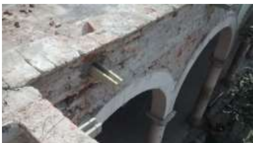
Zermeño Méndez, Salvador, se observan las gárgolas de barro, que en el caso de las columnas de cantera se ubicaron en donde ya estaban dichas gárgolas, 2016-04-18.
