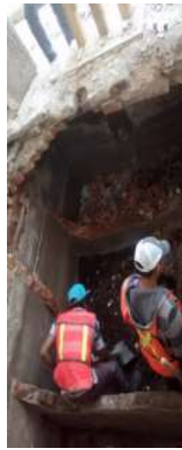
Zermeño Méndez, Salvador, En las tres imágenes se observa el aprovechamiento de la fosa séptica de 1939, para ser reutilizada y colocar en su lugar la cisterna de 10,000 litros marca Rotoplas, 2016-05 -13.
