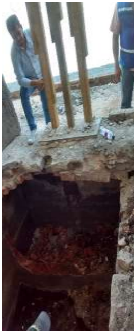
Zermeño Méndez, Salvador, En las tres imágenes se observa el aprovechamiento de la fosa séptica de 1939, para ser reutilizada y colocar en su lugar la cisterna de 10,000 litros marca Rotoplas, 2016-05 -13.
