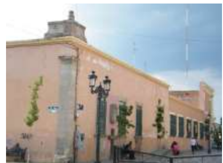
Zermeño Méndez, Salvador, fachadas en las calles 5 de Mayo y Hermenegildo Bustos, el momento en que la escuela se desocupó para iniciar la restauración del centro cultural, 2015-05 -16.
