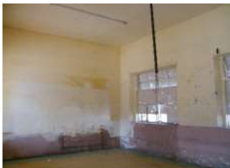
Zermeño Méndez, Salvador, humedad ascendente por capilaridad en el segundo salón de la crujía este, contigua al acceso principal, 2015-05 - 16.
