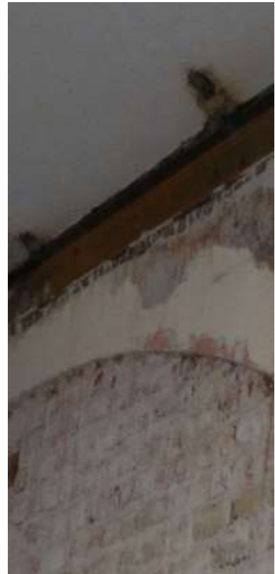
Zermeño Méndez, Salvador, se observa la colocación de vigas IPR's, su empotre arriba del arco de medio punto, para recibir los IPR's de las bóvedas escarzanas existentes. 2016-09-20.
