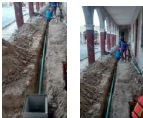
Zermelo Méndez, Salvador, En las dos imágenes se observa la colocación de registros y la red eléctrica, 2016-05 -25.
