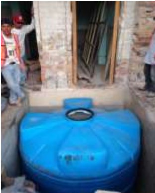
Zermeño Méndez, Salvador, En las tres imágenes se observa cómo se suministró y colocó la cisterna de 10,000 litros marca Rotoplas, que incluyó en su proceso; trazo y nivelación, así como la demolición del muro de 2.35 m x 1.50 m de 35 cm de espesor, retirando el material producto de la demolición fuera de la obra. A su vez la excavación se hizo con medios manuales de la fosa séptica, para colocar la cisterna a una profundidad de 3.50 profundidad; con un ancho de 2.8 m x 2.8 m de ancho, 2016-06 -27.
