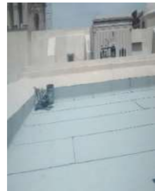
Zermeño Méndez, Salvador, En las 4 imágenes se observa la colocación de la carpeta asfáltica termofusionada Sika o Chovetec autorizada por el INAH, 2016-04-29,
