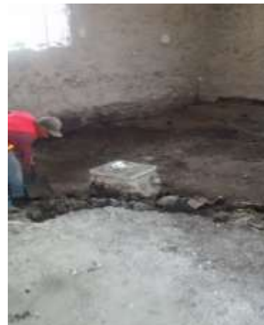
Zermeño Méndez, Salvador, se observa el tratamiento con cal para mejorar el suelo, previo a la capa de grava y tepetate, en la crujía sur en lo que va a conformar la bodega taller, 2016-04-08.
