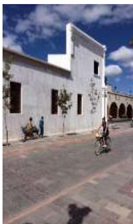
Zermeño Méndez, Salvador, Las ventanas de la escuela de 1939 eran vanos cuadrados de 2.10 m x 2.10 m, en la fachada en Hermenegildo Bustos, cambiando los módulos de los vanos de modo vertical, siguiendo el patrón de diseño de los vanos de la primera escuela de 1868, de 1.10 de ancho por 2.10 m, 2016-08 -11.
