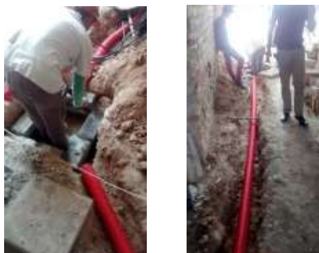
Zermelo Méndez, Salvador, En las dos imágenes se observa la red para descargar la línea de media, en la que se metió una red por todo el pórtico este de la construcción de 1939 con dos registro visitables uno de 60 cm por 80 cm y el otro de 60 cm por 60 cm; el primero de profundidad de 90 cm y el otro de 50 cm de profundidad, se desplantó sobre grava la línea seca y se usó tubería pad de 4 “, 2016-08 -16.
