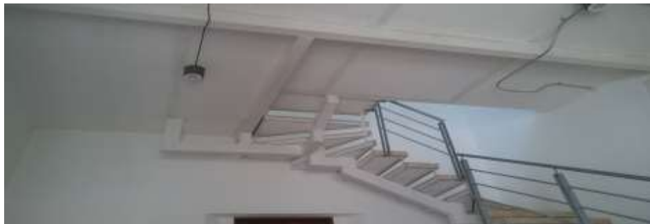
Zermeño Méndez, Salvador, se observa la escalera del salón de recepción, además debajo de ella se ubicó el SITE y el monitor para la recepción de imágenes de las salas de exposición, 2017-01-9.
