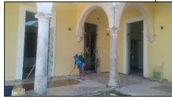
Pintura a la cal, preparada agregando a la mezcla sal previamente disuelta en agua, caseína, alumbre, en colores aceptados por el INAH, con pigmentos naturales, aplicado con brocha de cerdas naturales a cinco manos. Muro de Piedra brasa (Existente, espesor 0.70 M-1.00 M).
