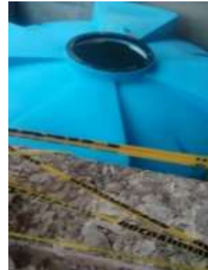
Zermeño Méndez, Salvador, En las tres imágenes se observa cómo se suministró y colocó la cisterna de 10,000 litros marca Rotoplas, que incluyó en su proceso; trazo y nivelación, así como la demolición del muro de 2.35 m x 1.50 m de 35 cm de espesor, retirando el material producto de la demolición fuera de la obra. A su vez la excavación se hizo con medios manuales de la fosa séptica, para colocar la cisterna a una profundidad de 3.50 profundidad; con un ancho de 2.8 m x 2.8 m de ancho, 2016-06 -27.
