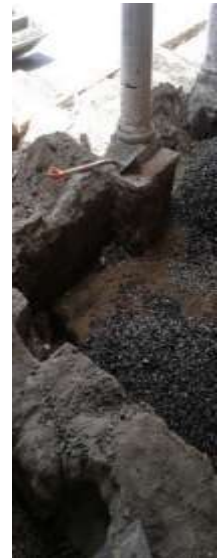
Zermeño Méndez, Salvador, se observa la capa tepetate y la capa de grava en el perímetro del pórtico perimetral sur, 2016-04-29.
