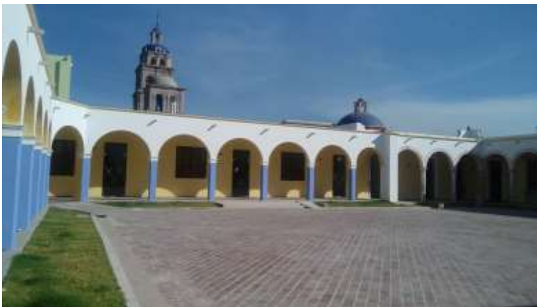
Zermeño Méndez, Salvador, patio principal, arcada este en la que se ve el corte histórico de 1862 y 1939, por el cambio de las columnas de cantera a tabique, 2017-01-24
