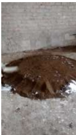
Zermeño Méndez, Salvador, se observa la arena y la cal apagada, previa a hacer la mezcla para los repellados en muros, 2016-06-13.
