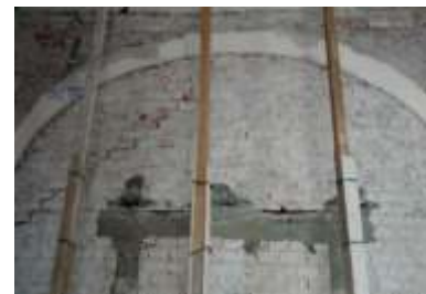
Zermeño Méndez, Salvador, colocación del marco rígido de concreto en el muro tapeado, donde existe una continuidad espacial a través de un arco de piezas de cantera, para lograr la continuidad espacial con la sala dedicada a la obra de Hermenegildo Bustos, 2016-08-18.
