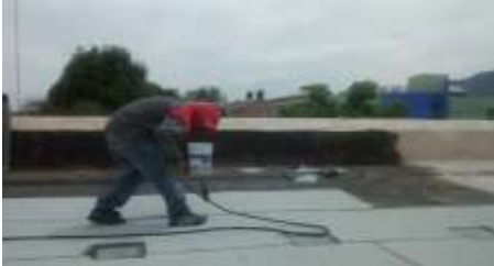
Zermeño Méndez, Salvador, se observa la colocación de la carpeta asfáltica termofusionada Sika autorizada por el INAH, 2016-04-25.
