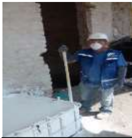
Zermeño Méndez, Salvador, se observa el contenedor de plástico reforzado, donde se menea la cal viva,
