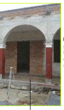
Retiro de aplanados actuales que pueden dañar los materiales de los muros, y para observar la dimensión total de las grietas en muro. Muro de tabique rojo (Existente).
