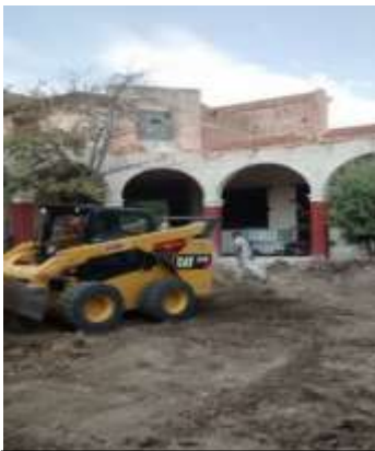
Zermeño Méndez, Salvador, se observa el proceso de demolición del firme y aljibe anterior, dado la diferencia de niveles que tenía y con el afán de construir un patio armónico y homogéneo se decidió desarrollar otra plataforma, 2016-04-08.
