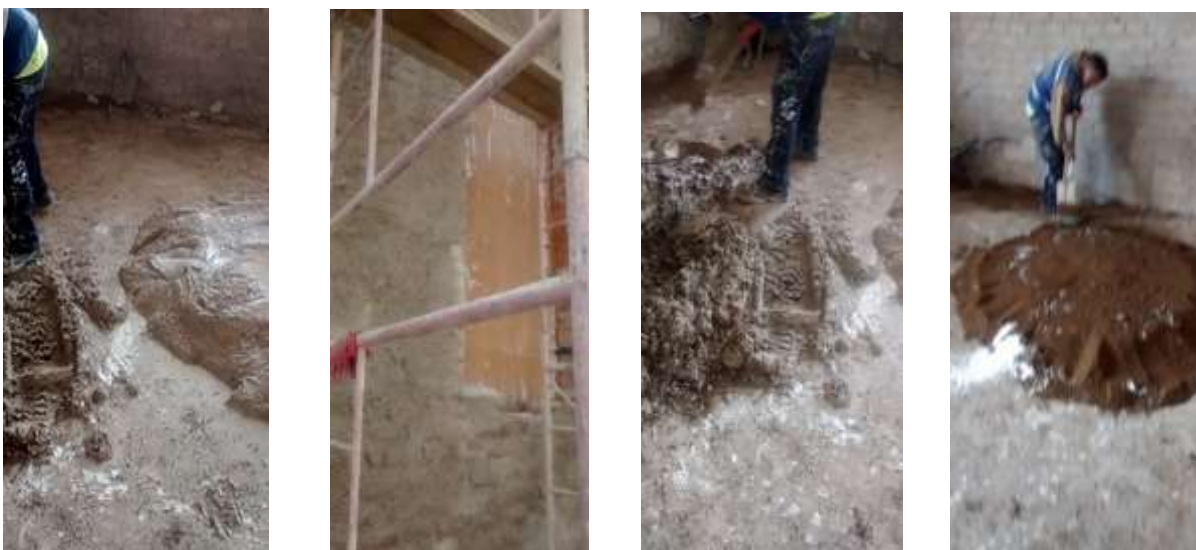
Zermeño Méndez, Salvador, en las cuatro imágenes se observa el proceso para la mezcla que se utilizó para repellar los muros, en el cual se empleó una cubeta de 19 litros de cal, por 5 botes de arena, con media cubeta de acetato de polivinilo (Pegamento Toro) y se diluyó en una cubeta de 19 litros. 2016-06-13.
