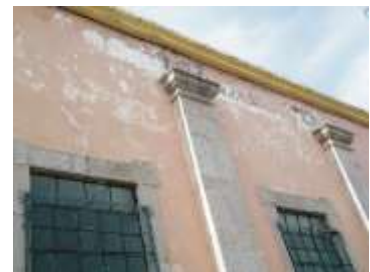
Zermeño Méndez, Salvador, detalle de vanos y pilastras de cantera adosada en la calle 5 de Mayo, 2015-05 -16.
