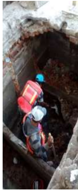
Zermeño Méndez, Salvador, En las tres imágenes se observa el aprovechamiento de la fosa séptica de 1939, para ser reutilizada y colocar en su lugar la cisterna de 10,000 litros marca Rotoplas, 2016-05 -13.
