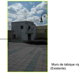
Muro de tabique rojo (Existente).
