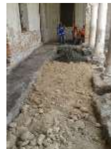
Zermeño Méndez, Salvador, se observa la capa tepetate y la capa de grava en el perímetro del pórtico perimetral sur, 2016-05-18.
