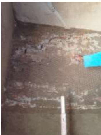
Zermeño Méndez, Salvador, en las dos imágenes se observa el tratamiento que se le dio a las grietas en tabique, empezando por eliminar polvo y aplicando agua a presión para lavar la grieta, colocar una cercha y desarrollar la inyección, 2016-05-18.
