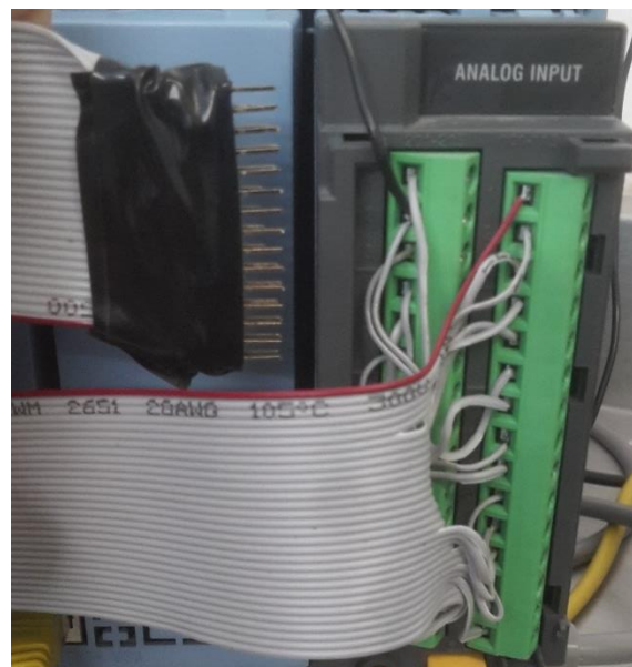
Figura 4.10 Instalación cable IDE
