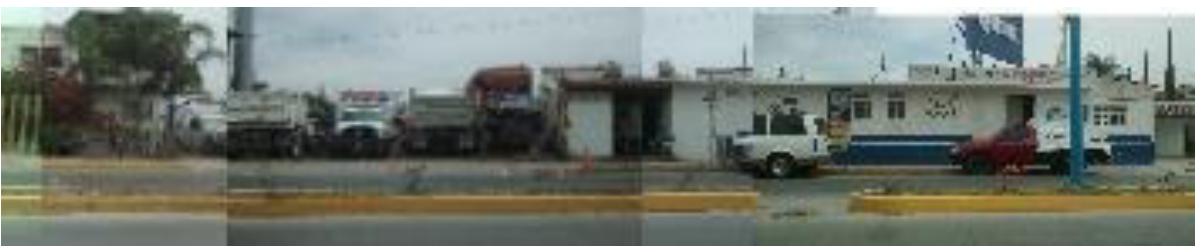
Ilustración 45 Parte 5 de la fachada noreste (Fuente: Elaboración personal)
