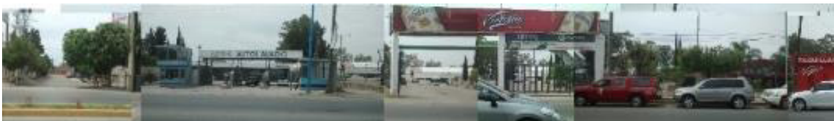
Ilustración 37 Parte 3 de la fachada suroeste (Fuente: Elaboración personal)
