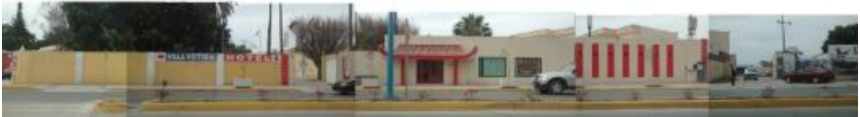
Ilustración 35 Parte 1 de la fachada suroeste (Fuente: Elaboración personal)
