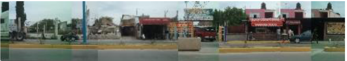
Ilustración 43 Parte 3 de la fachada noreste (Fuente: Elaboración personal)
