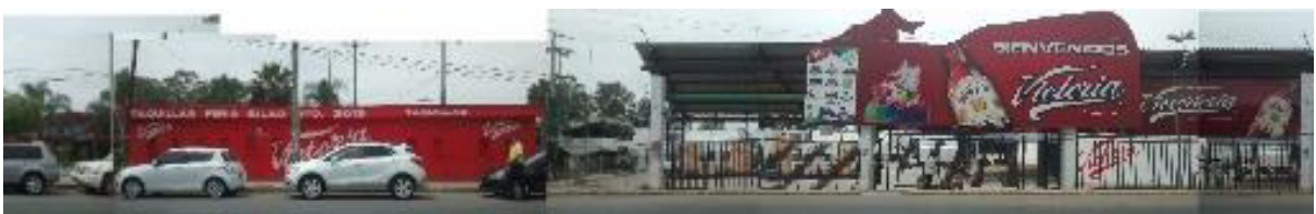
Ilustración 38 Parte 4 de la fachada suroeste (Fuente: Elaboración personal)
