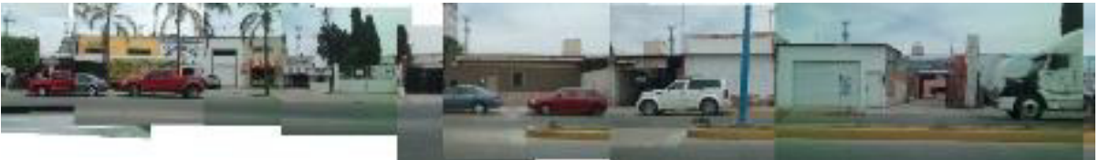
Ilustración 42 Parte 2 de la fachada noreste (Fuente: Elaboración personal)
