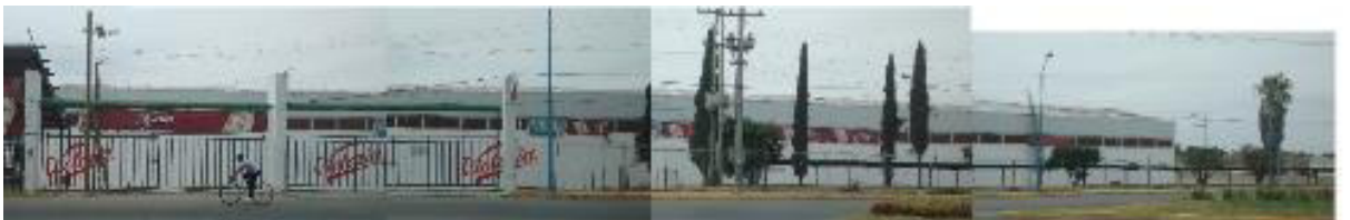
Ilustración 39 Parte 5 de la fachada suroeste (Fuente: Elaboración personal)
