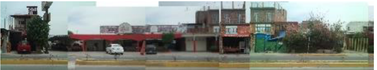
Ilustración 44 Parte 4 de la fachada noreste (Fuente: Elaboración personal)
