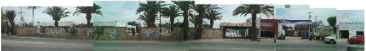
Ilustración 41 Parte 1 de la fachada noreste (Fuente: Elaboración personal)
