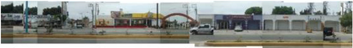
Ilustración 36 Parte 2 de la fachada suroeste (Fuente: Elaboración personal)
